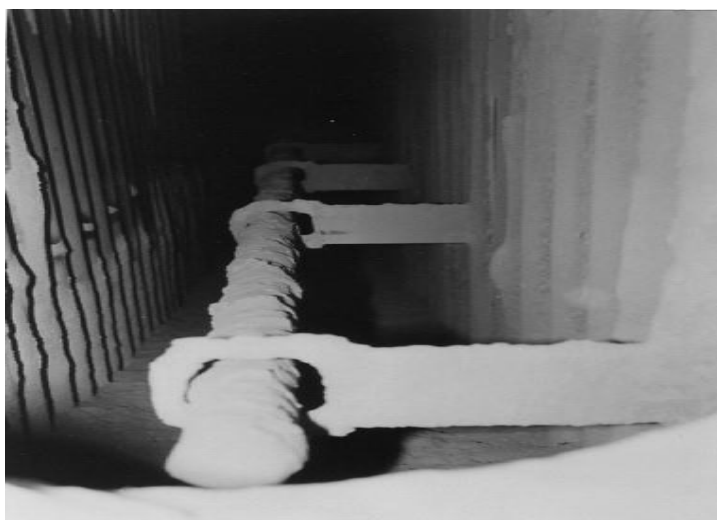
Εικόνα 4. Προσκόλληση σωματιδίων τέφρας στους αυλούς του λέβητα.
