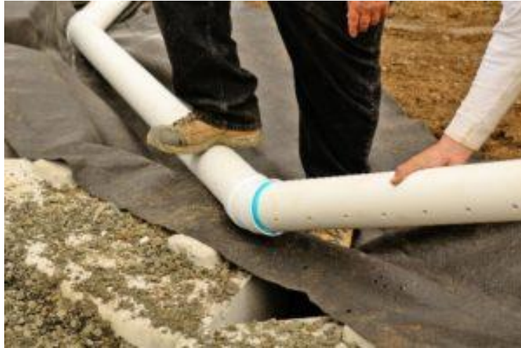
Εικόνα 16 Χρήση γεωυφάσματος για την αποστράγγιση διερχόμενου σωλήνα (minet.ro)
