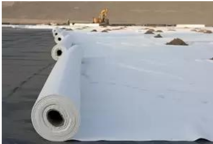
Εικόνα 17 Επαφή εδάφους - γεωυφάσματος – γεωμεμβράνης (minet.ro)
