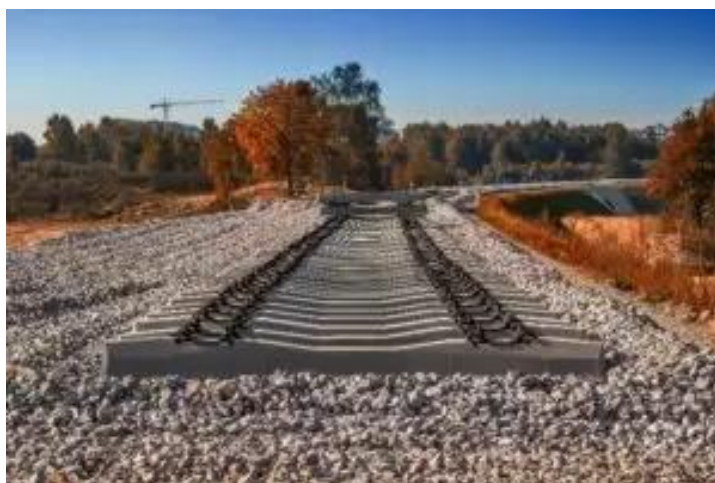
Εικόνα 15 Κατασκευασμένη σιδηροδρομική γραμμή, στην οποία χρησιμοποιήθηκε γεωύφασμα (minet.ro)
