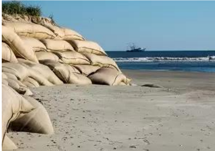
Εικόνα 18 Επιχώματα στα οποία έχουν χρησιμοποιηθεί γεωυφάσματα (minet.ro)
