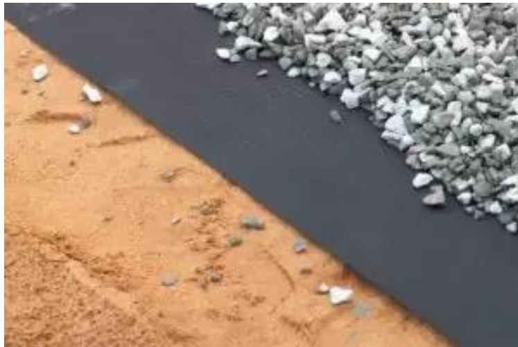
Εικόνα 14 Χρήση γεωυφάσματος σε έργο οδοποιίας (minet.ro)
