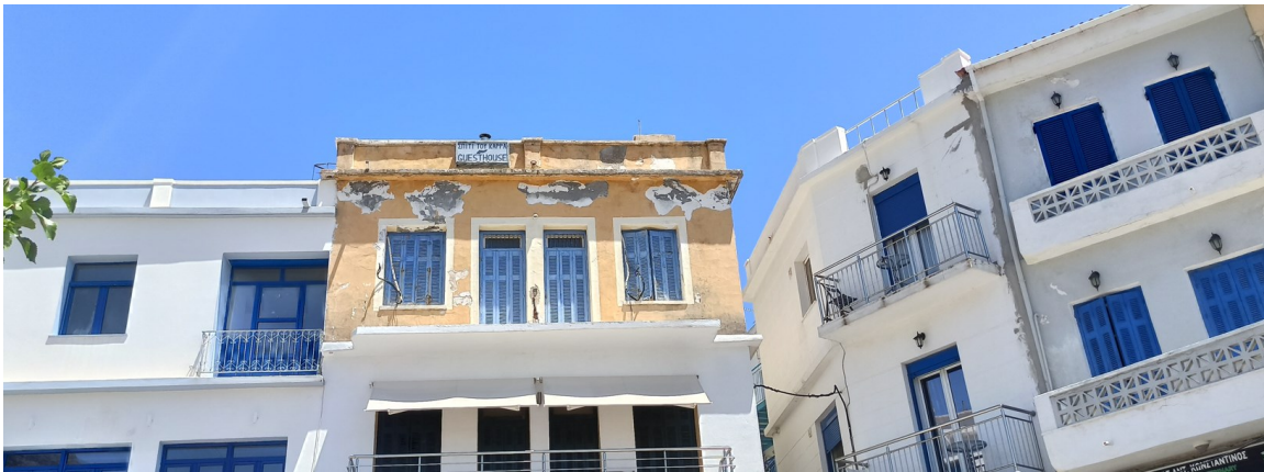
Εικόνα 19. Κτίρια στον Άγ. Κήρυκο. Φαίνονται οι διαφορετικές περιόδους κατασκευής και οι προσθήκες ορόφων. Προσωπικό αρχείο.
