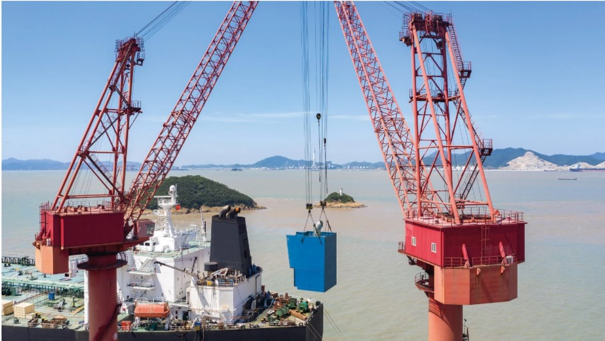
Εικόνα 29: Εγκατάσταση συστήματος καθαρισμού καυσαερίων (scrubber)
