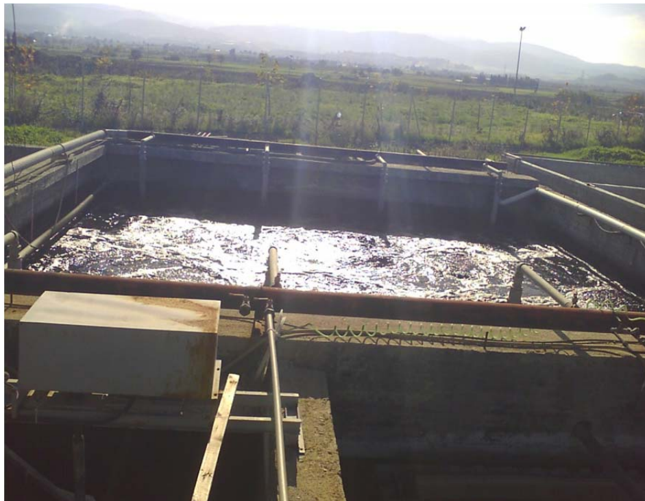
Σχήμα 4.3: Επεξεργασμένα υγρά απόβλητα του βαφείου-φινιριστηρίου στην περιοχή των Οиноφύτων Βοιωτίας
