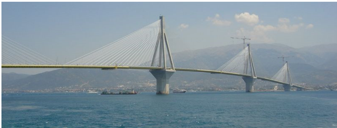
Εικόνα 10: Η γέφυρα ζεύξης Ρίου - Αντίρριου
