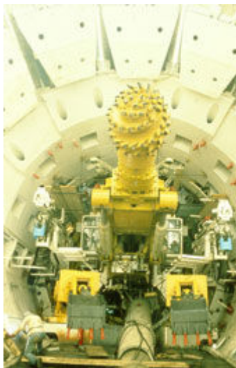
Σχήμα 6.3.1.1: Μηχάνημα ανοικτού μετώπου με ασπίδα (OFS) Πηγή : www.ametro.gr
