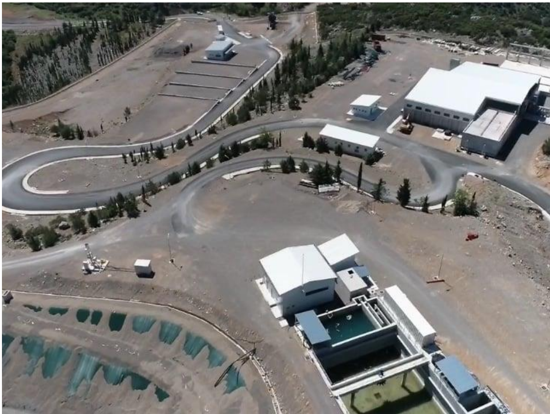
Εικόνα 23: Μονάδα Επεξεργασίας Στερεών Αποβλήτων και ΧΥΤΥ, Πηγή: fokidanews.gr
