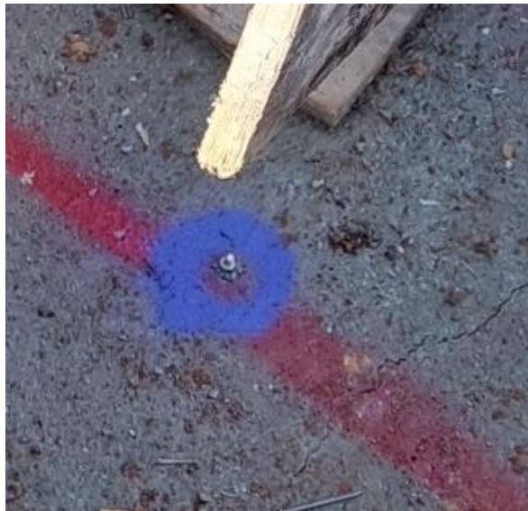
Εικόνα 3.1: Υλοποιημένο σημείο χάραξης με την χρήση καρφιού σε εργοτάξιο.
