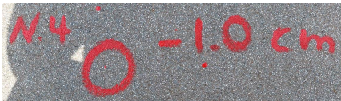
Εικόνα 4.10: Υλοποιημένο σημείο 3d χάραξης σημείου 4.
