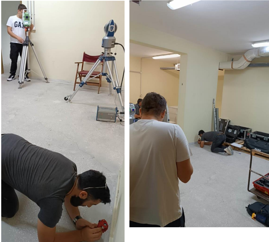
Εικόνα 4.16: Προσπάθεια χάραξης του σημείου 4 του κύκλου. Στην εικόνα φαίνεται ο χειριστής του γεωδαιτικού σταθμού να κατευθύνει τον στοχοφόρο.
