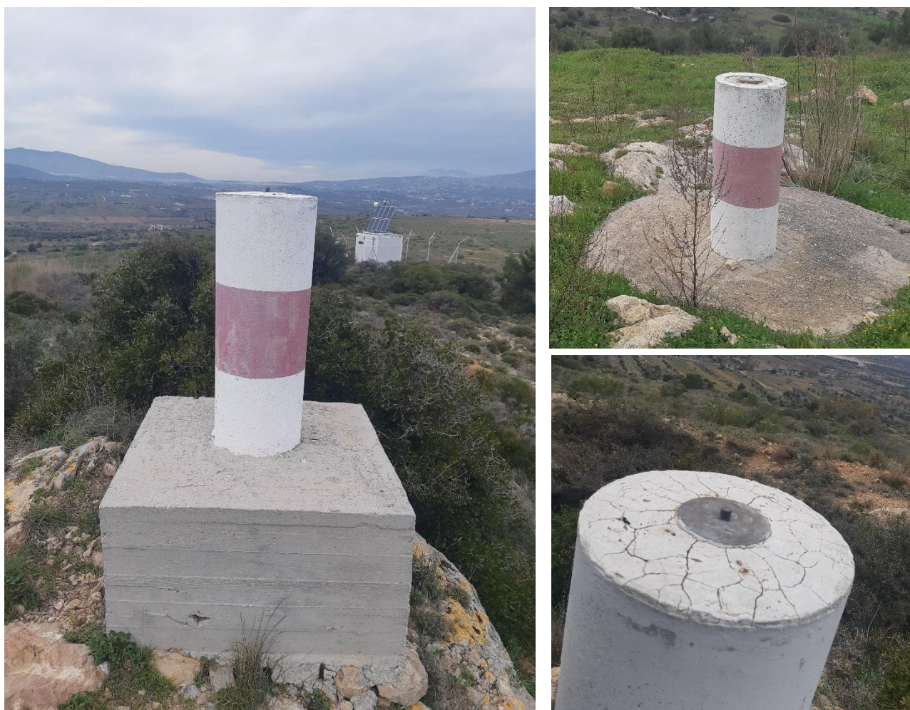
Εικόνα 2.2: Βάθρα από οπλισμένο σκυρόδεμα που φέρουν στην στέψη τους κατασκευή για εξαναγκασμένη κέντρωση γεωδαιτικών σταθμών και στόχων. (Βάθρα Αερολιμένα Αθηνών)
