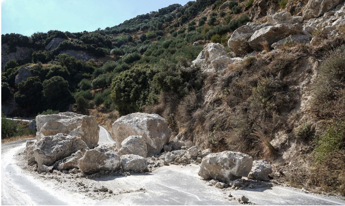
Εικόνα 4.11: Κατολίσθηση Σεπτεμβρίου 2023 στην επαρχιακή οδό Πούντας-Καλαβρύτων.
