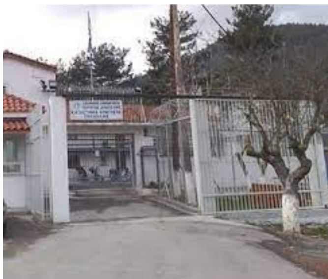
Εικόνα 27: Εξωτερική άποψη του Σωφρονιστικού Καταστήματος Τρίπολης. Πηγή: https://www.patrisnews.com/ . Ανάκτηση: 8/2023
