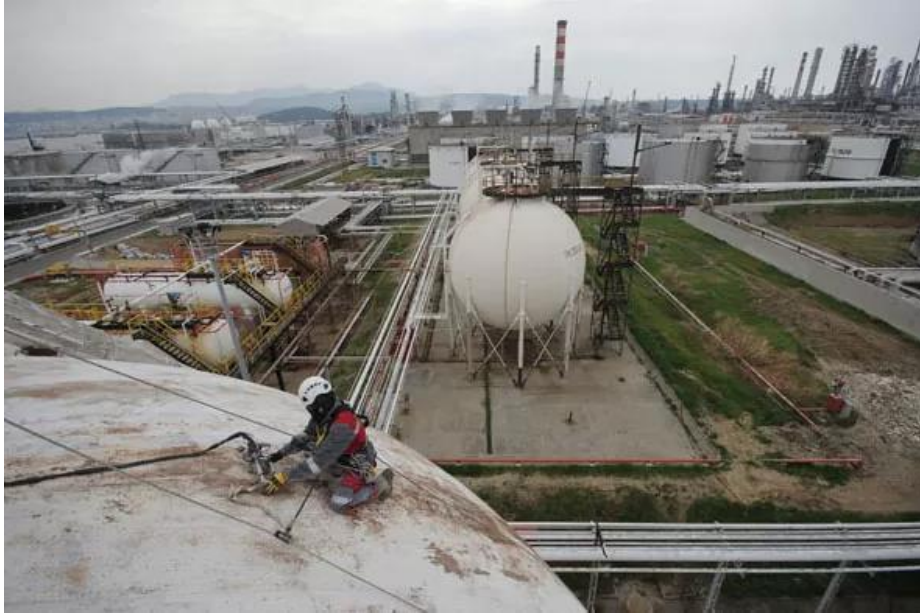
Σχήμα 24: Έλεγχος δεξαμενής
