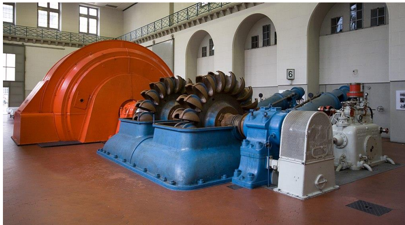
Σχ. 3-6. Υδροστρόβιλος τύπου Pelton [73].
