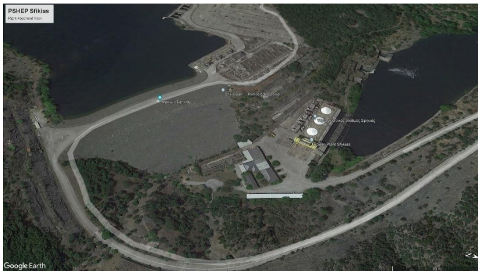
Σχ. 4-27. ΣΑΗΕ Σφικιάς – Όψη από δεξιά αντέρεισμα κατόντη του φράγματος.
