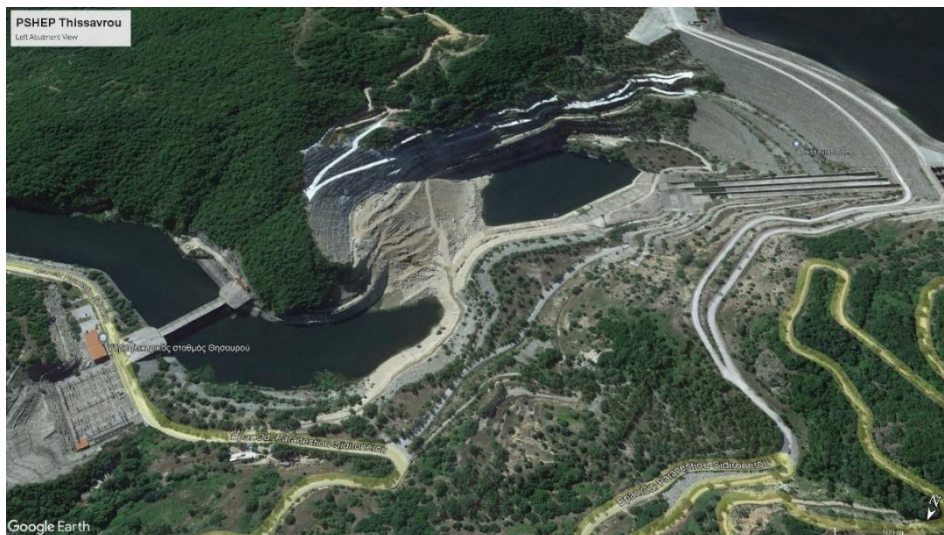
Σχ. 4-34. ΣΑΗΕ Θησαυρού – Όψη από αριστερά αντέρεισμα κατόντη του φράγματος.
