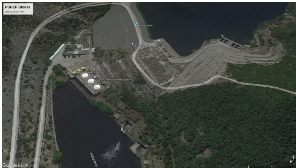
Σχ. 4-28. ΣΑΗΕ Σφικιάς – Όψη από αριστερά αντέρεισμα κατόντη του φράγματος.
