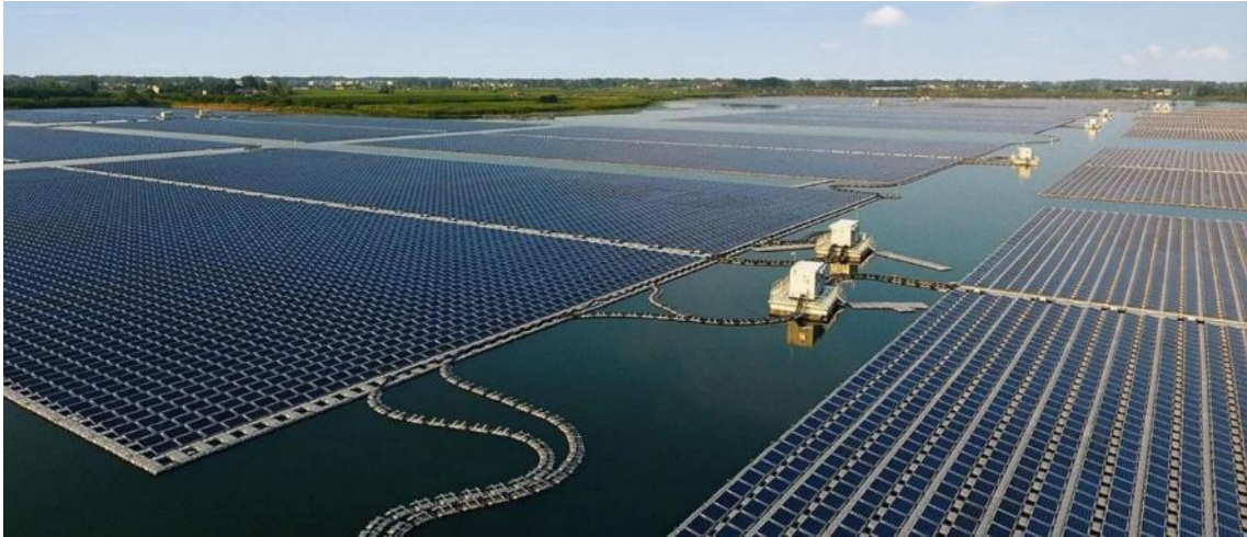
Σχ. 1-21: Πλωτό φωτοβολταϊκό Πάρκο [26] (Alqueva reservoir – Portugal)
