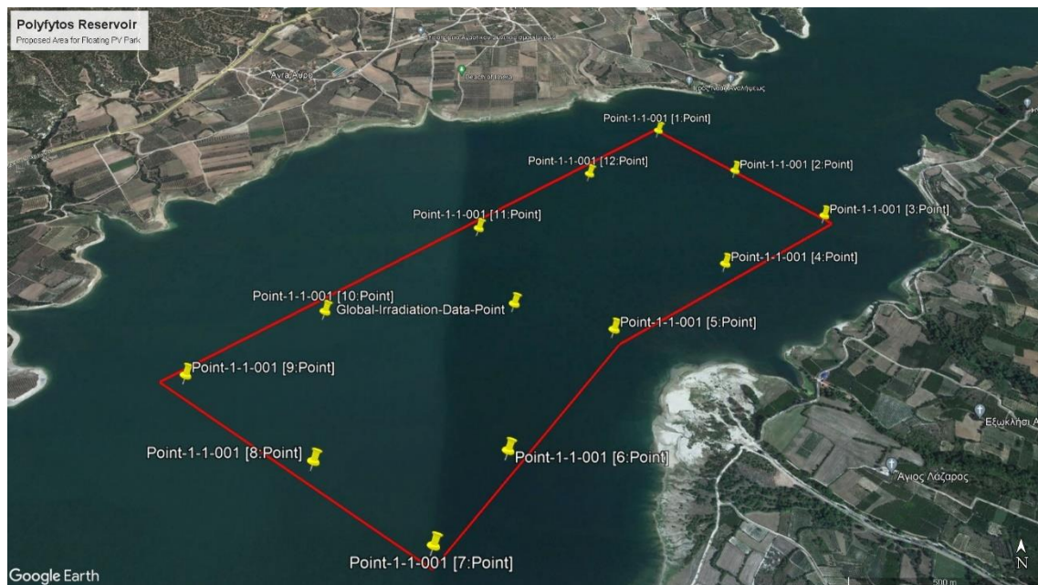
Σχ. 4-10. Πλωτό Φ/Β Πάρκο Συγκροτήματος Αλιάκμονα.
