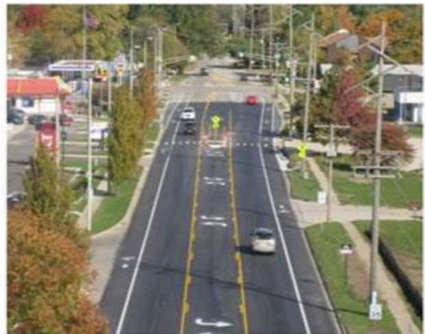
Σχήμα 2.4 : Οδός που ευνοεί τις ενεργές μετακινήσεις, με νησίδια διαχωρισμού λωρίδων, διαβάσεις πεζών και λωρίδα ποδηλάτων (Πηγή: TDM Encyclopedia, 2018)
