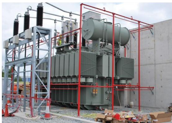
Εικόνα 27: Παράδειγμα συστήματος Water Spray (Curtain) System σε Σταθμό Ηλεκτροπαραγωγής 49
