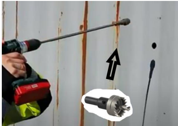
Εικόνα 30: Διάτρηση μέσω ηλεκτρικού εργαλείου και ποτηροτρύπανου (EMSA, 2023)
