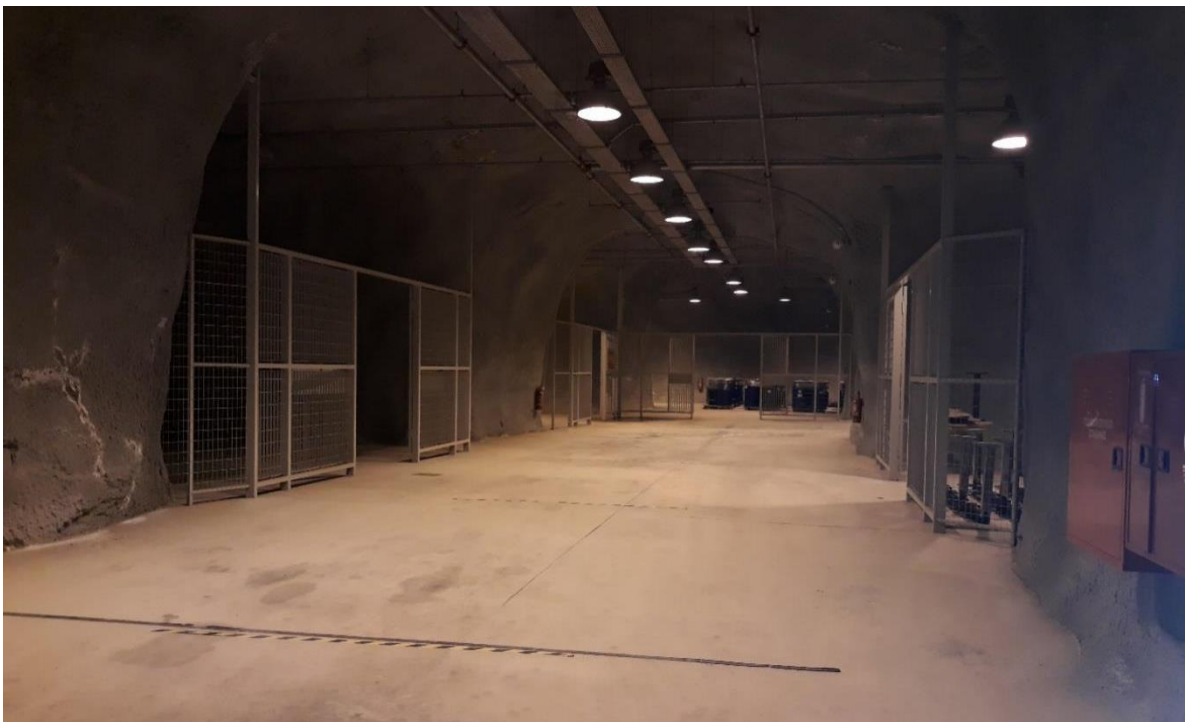
Εικόνα 5.1-7: Άποψη του κύριου διαδρόμου που οδηγεί στην στοά προσπέλασης.
