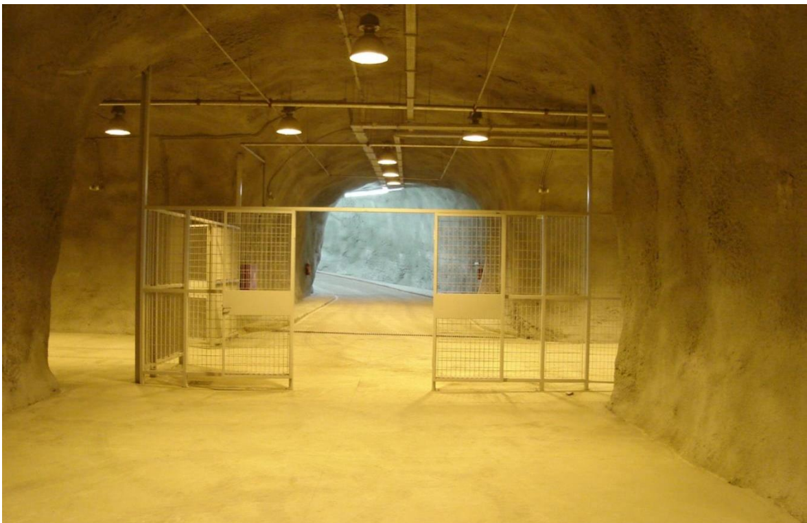
Εικόνα 5.1-1: Άποψη της στοάς προσπέλασης από το αποθηκευτικό τμήμα του χώρου.
