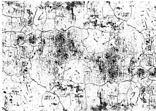
Εικόνα 3.2.2-7: Το bump που δόθηκε για το εκτοξευόμενο σκυρόδεμα.
