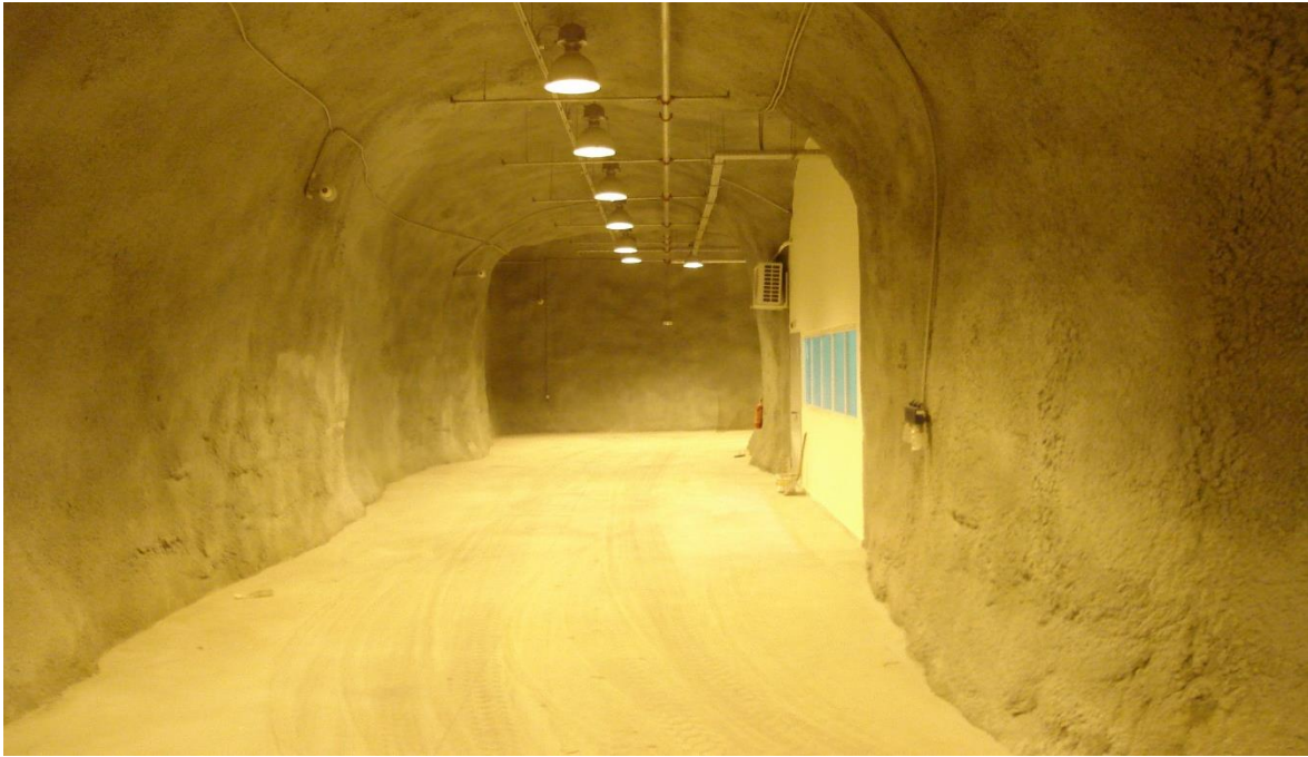
Εικόνα 5.1-10: Ο κύριος διάδρομος που οδηγεί στα γραφεία και στο κλιμακοστάσιο.
