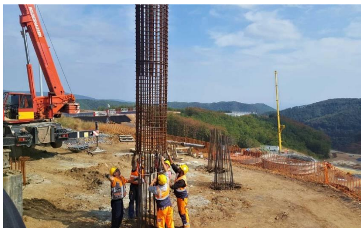
Εικόνα 6. Φρεατοπάσσαλοι, (Geoerevna, n.d.)
