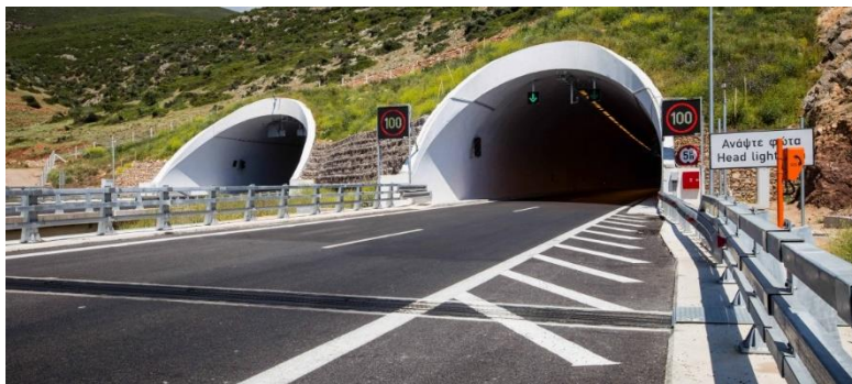
Εικόνα 8. Σήμανση πριν την είσοδο στο υπόγειο τμήμα της σήραγγας, (Kentriki
