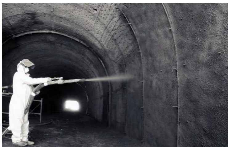
Εικόνα 5. Εκτοξευόμενο σκυρόδεμα, (Μραμπάλις, n.d.)
