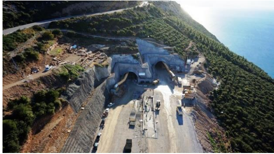
Εικόνα 1. Στάδιο κατασκευής στομιών, σήραγγα Κλόκοβας, (Agrinio Press, χ.χ.)
