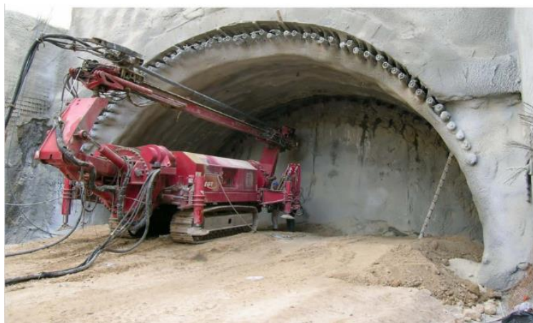
Εικόνα 4. Δοκοί προπορείας, (Σοφιανός, 2018)
