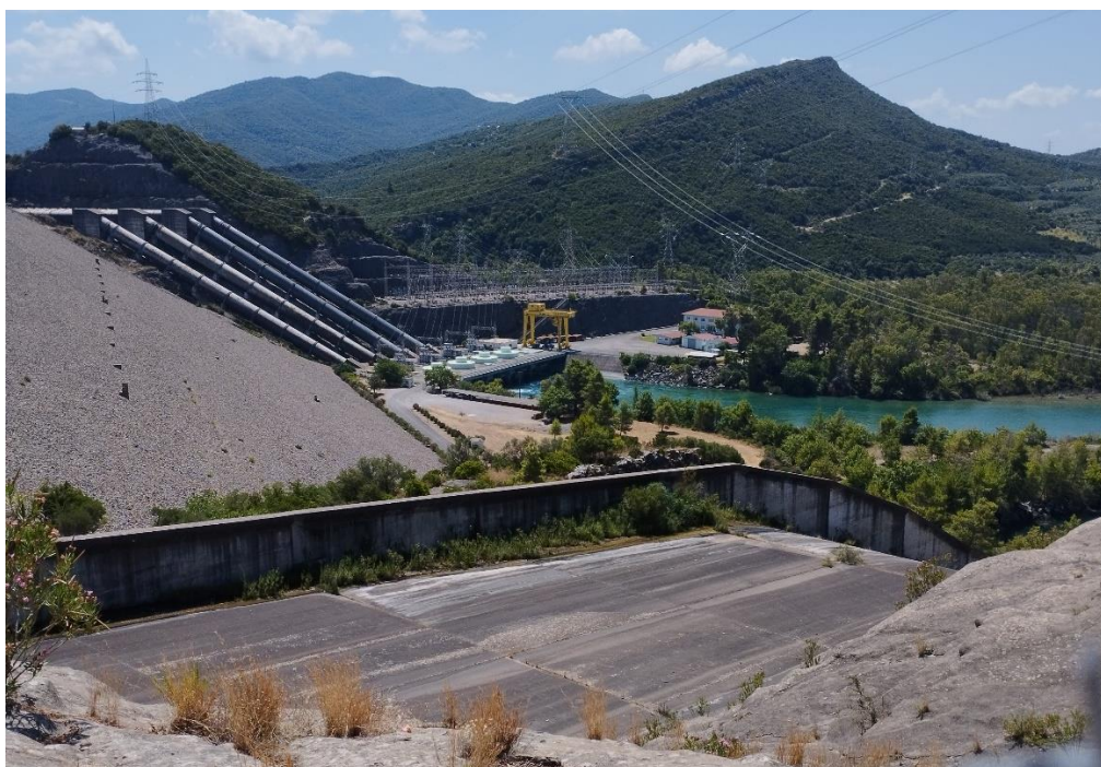
Εικόνα 3.2: Φράγμα Καστρακίου. Στο μπροστινό μέρος διακρίνεται ο υπερχειλιστής και στο βάθος οι αγωγοί πτώσης και ο σταθμός παραγωγής ενέργειας
