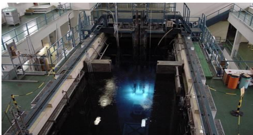
Εικόνα 5: Εικόνα από τον ερευνητικό πυρηνικό αντιδραστήρα του ΕΚΕΦΕ «Δημόκριτος». Η λειτουργία του αντιδραστήρα ήταν σε ισχύ 5 MW και στην εικόνα διακρίνεται η ακτινοβολία Cherenkov.[84]
