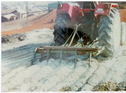
(c) Limestone cover Κάλυμμα ασβεστολίθου.
