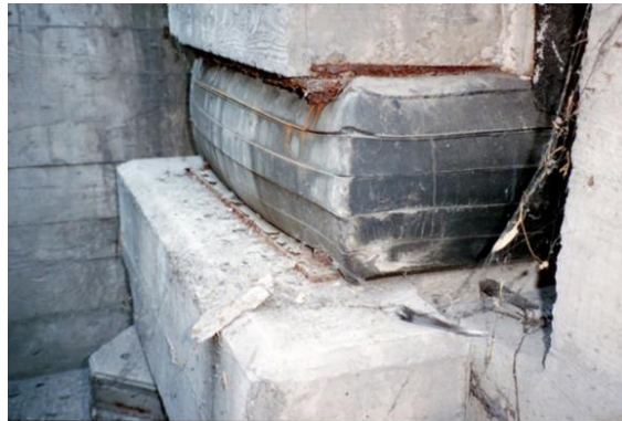
Εικόνα 9: Εφέδρανα συγκολλημένου καουτσούκ στην πρώτη εφαρμογή τους
