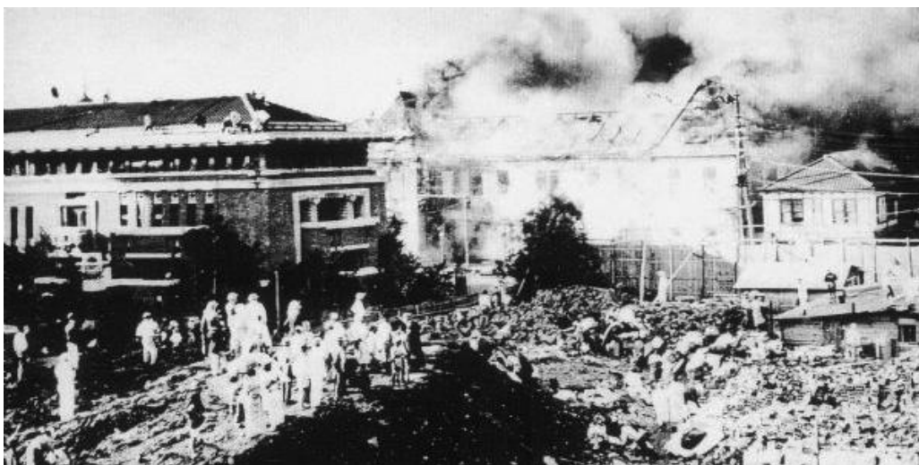
Εικόνα 8: Το ξενοδοχείο Imperial (στα αριστερά) στο Τόκυο κατασκευασμένο το 1921 πάνω από ένα στρώμα καλού εδάφους και πιο βαθιά λάσπη αποτελεί το πρώτο σεισμικά μονωμένο κτίριο στην σύγχρονη εποχή και ανταπεξήλθε στον σεισμό του 1923 [17], [18].
