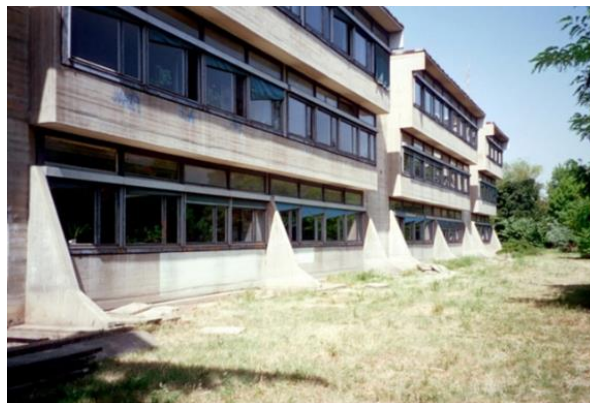
Εικόνα 10: Το πρώτο κτίριο στο οποίο εφαρμόστηκαν εφέδρανα από καουτσούκ, ένα σχολείο στα Σκόπια το 1969.[20]
