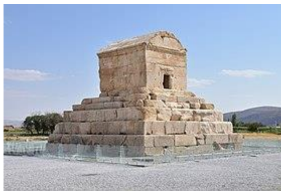
Εικόνα 6: Το μασωλείο του Cyrus the Great κατασκευασμένο το 500 π.Χ. αποτελεί την πρώτη εφαρμογή της σεισμικής μόνωσης στον κόσμο [12]
