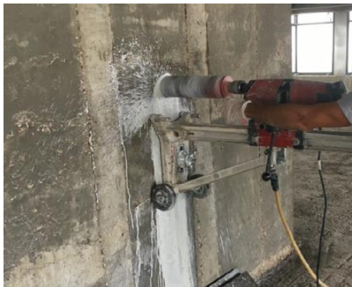
Σχήμα 2.5: Παράδειγμα λήψης πυρήνα από τοίχιο κλιμακοστασίου. [21]
