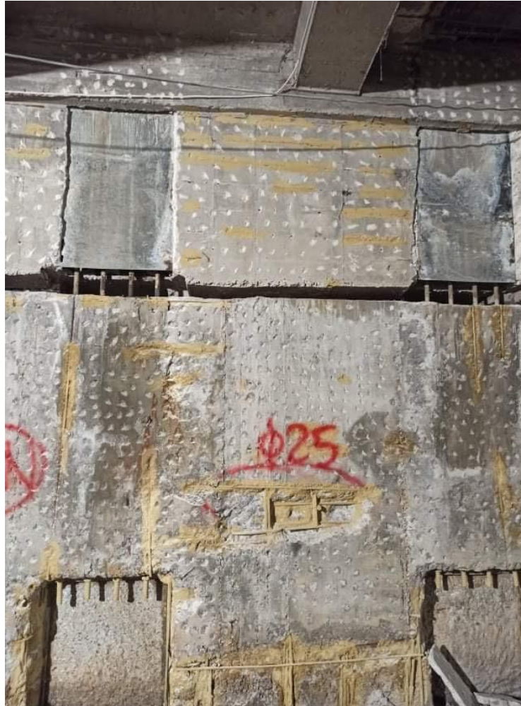
Σχήμα 3.13: Παράδειγμα Αλεξίσειμων Συνδέσεων στον Πύργο του Πειραιά. Πρόκειται για τις μεταλλικές ράβδους που διαπερνούν τον αντισεισμικό αρμό (από προσωπικό αρχείο)
