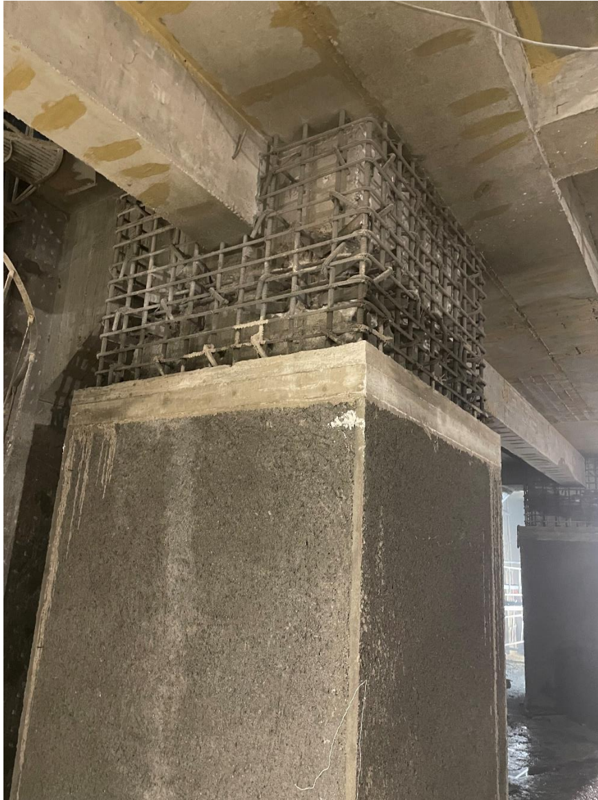
Σχήμα 1.8: Παράδειγμα κατάργησης αντισεισμικού αρμού με τσιμεντοκονίαμα (από προσωπικό αρχείο)
