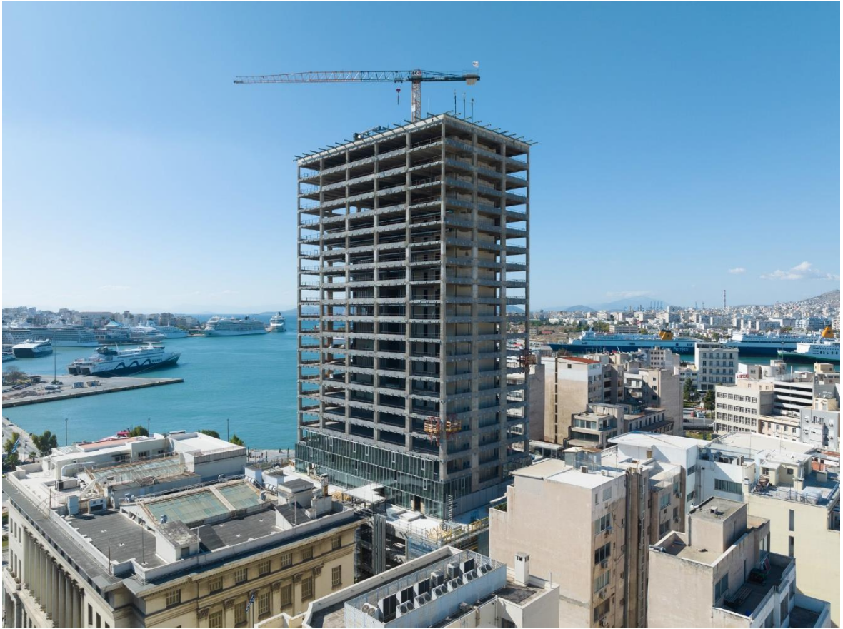
Σχήμα 1.6: Ο Πύργος αναδιαμορφώνεται, Φεβρουάριος 2023 (από pireustower.gr [35])
