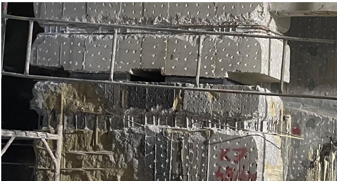
Σχήμα 3.14: Αλεξίσειμοι Δίσκοι (κομμάτι ανωδομής) και Αλεξίσειμες Στηρίξεις (ελαστομεταλλικά εφέδρανα) στο Β' υπόγειο του Πύργου Πειραιά (από προσωπικό αρχείο)
