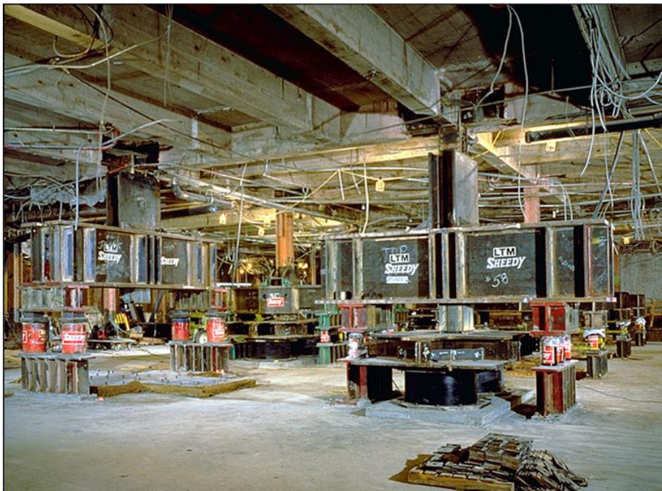
Σχήμα 5.6: Στιγμιότυπο από την εγκατάσταση των εφεδράνων στη θεμελίωση του δημαρχείου του Σαν Φρανσίσκο. Τα υποστυλώματα, αφού ενισχυθούν, κόβονται στο άκρο τους και εισάγονται οι μονωτήρες. (από Κ. Παπανίκος [23])
