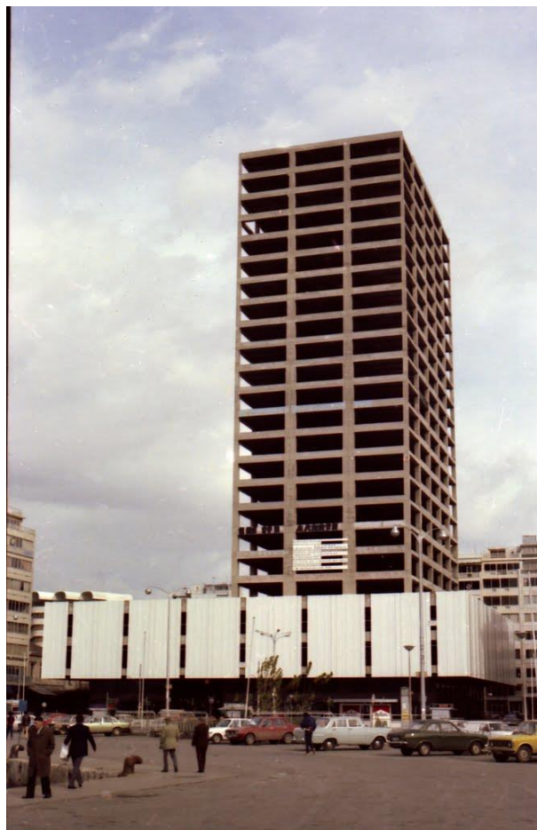
Σχήμα 1.5: Ο Πύργος το 1980. Παρατηρείται η έλλειψη των γυάλινων και μεταλλικών ελασμάτων στην όψη (από mario.net [19])
