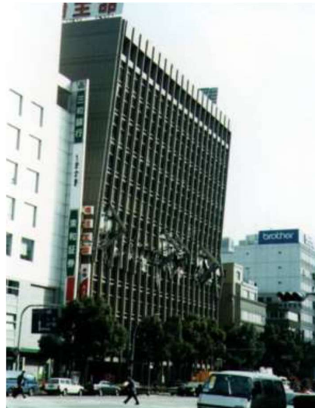
Σχήμα 1-3. Κατάρρευση κτιρίων λόγω ακανονικότητας καθ' ύψος – Σεισμός Izmit M = 7.4 (αριστερά), σεισμός Kobe M = 6.8 (δεξιά).
