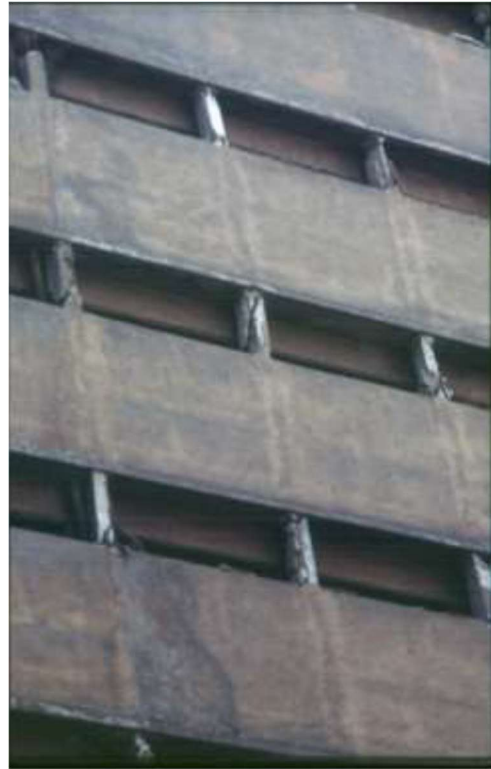
Σχήμα 1-6. Αστοχία κοντού υποστυλώματος υπό σεισμική δράση – Σεισμός Managua, Nicaragua, 1972 (αριστερά), σεισμός Mexico City, 1985 (δεξιά).
