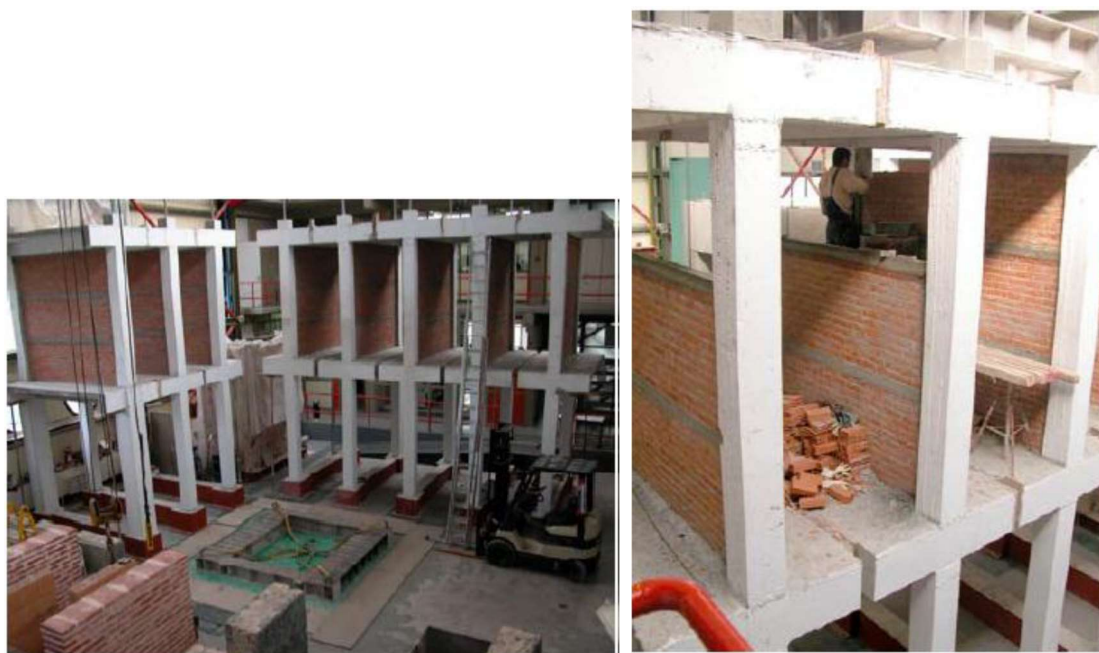
Σχήμα 4-1. Πειραματικά δοκίμια σε φάση κατασκευής.
