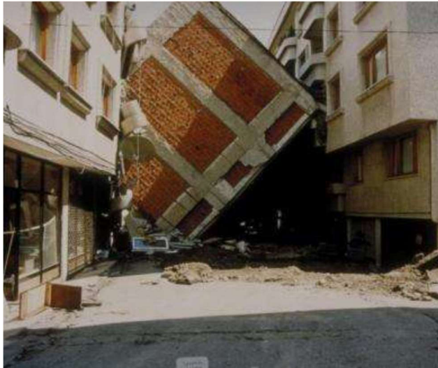
Σχήμα 1-3. Κατάρρευση κτιρίων λόγω ακανονικότητας καθ' ύψος – Σεισμός Izmit M = 7.4 (αριστερά), σεισμός Kobe M = 6.8 (δεξιά).
