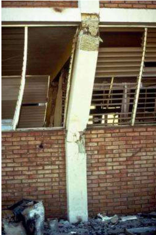
Σχήμα 1-6. Αστοχία κοντού υποστυλώματος υπό σεισμική δράση – Σεισμός Managua, Nicaragua, 1972 (αριστερά), σεισμός Mexico City, 1985 (δεξιά).
