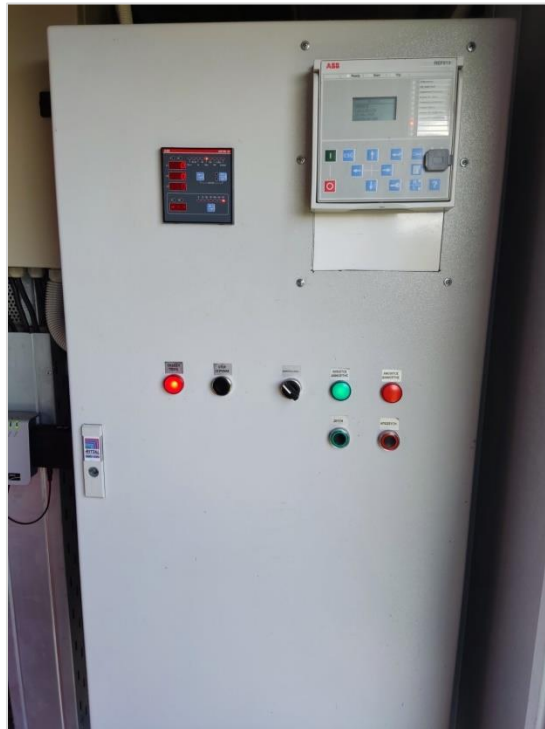
Εικόνα 2.7 Φωτογραφία από το έργο του Γενικού Πίνακα Μ.Τ. (2023)
