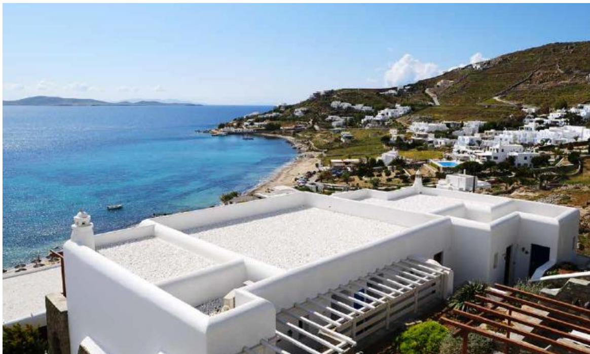
Εικόνα 21: Βαφή οροφής με χρώματα καλής ανακλαστικής συμπεριφοράς
