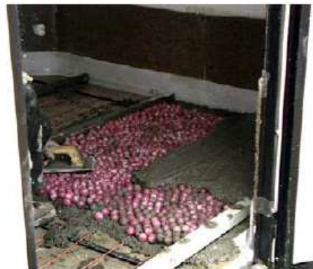
ΣΧΗΜΑ 7.31 :Διάταξη ξηρού συστήματος ενδοδαπέδιας θέρμανσης
