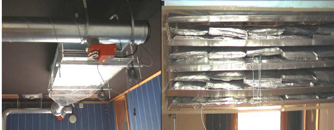
ΣΧΗΜΑ 7.1: (Εναλλάκτης θερμότητας ενισχυμένος με ΥΑΦ. Στη δεξιά φωτογραφία διακρίνονται τα φύλλα στο εσωτερικό του εναλλάκτη και τις συσκευασίες με το ΥΑΦ τοποθετημένες επάνω τους.)
