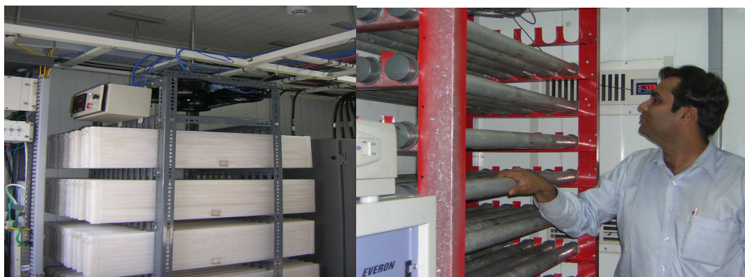
ΣΧΗΜΑ 7.9: Συσκευασίες ΥΑΦ (πλάκες και κύλινδροι) που χρησιμοποιούνται σε τηλεπικοινωνιακά κουβούκλια
