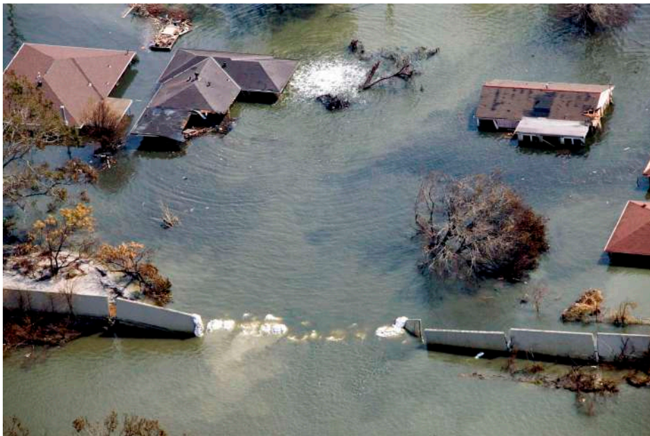
Εικόνα 19: Τμήμα του φράγματος που κατέρρευσε στο Βιομηχανικό Κανάλι και πλημμύρισε το Κατώτατο Ένατο Διαμέρισμα.
