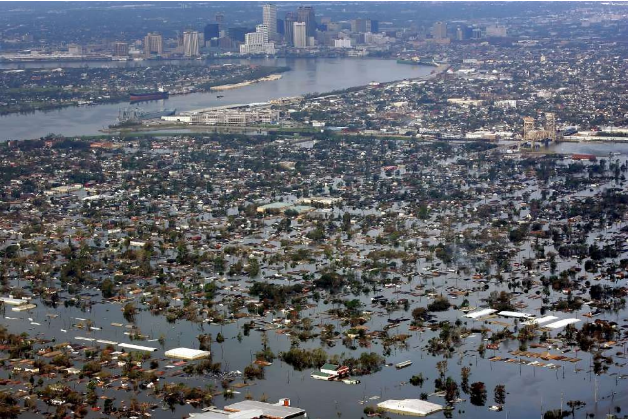
Εικόνα 18: Η πλημμυρισμένη Νέα Ορλεάνη (30/9/2005). Σε πρώτο πλάνο το Κατώτατο Ένατο Διαμέρισμα, πίσω του το Βιομηχανικό κανάλι. Κάθετα κατεβαίνει ο Μισσισιπιπής και στο βάθος διακρίνεται το επιχειρηματικό κέντρο της πόλης (Central Business District).
