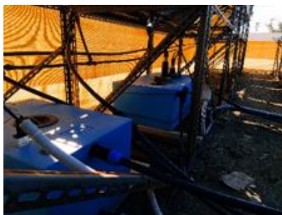
Εικόνα 41: Δεξαμενές ρύθμισης ανακτώμενου νερού (αριστερά) και άλμης (δεξιά) του MSS
