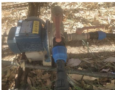
Εικόνα 44: Παροχέτευση παραγόμενου νερού από το MSS στη δεξαμενή άρδευσης
