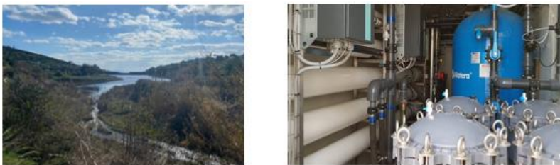
Εικόνα 20: Το φράγμα Βακετά (αριστερά) και μονάδα αφαλάτωσης (δεξιά) στη Χώρα Τήνου
