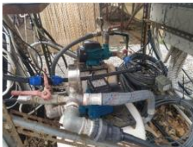
Εικόνα 37: Οι “δίδυμες” αντλίες θαλασσινού νερού του HYDROS
