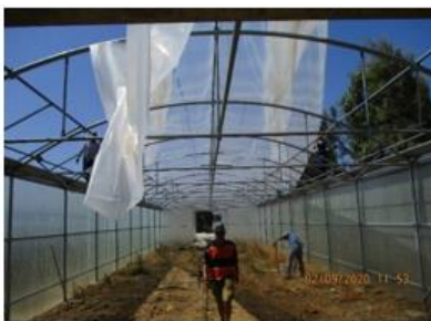
Εικόνα 53: Η κατασκευή του PGH
