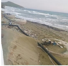
Εικόνα 33: Πηγάρια διήθησης και άντλησης του θαλασσινού νερού προς αφαλάτωση
