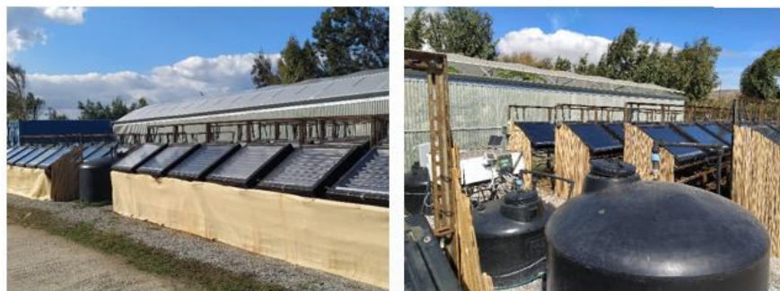
Εικόνα 30: Το σύστημα Mangrove Still στο νησί της Τήνου
