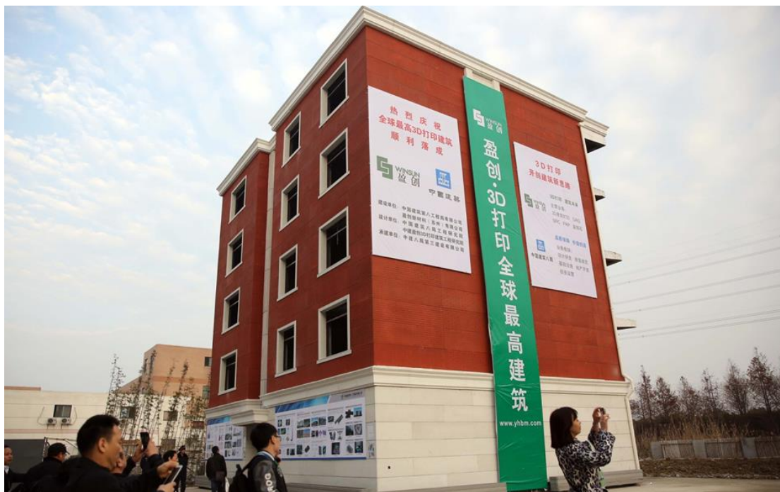
Σχήμα 2. 6 : Πενταώροφο τρισδιάστατα εκτυπωμένο οίκημα στα περίχωρα της πόλης Σουτσού, στην Ανατολική Κίνα (σχήμα από kathimerini, 2015).
