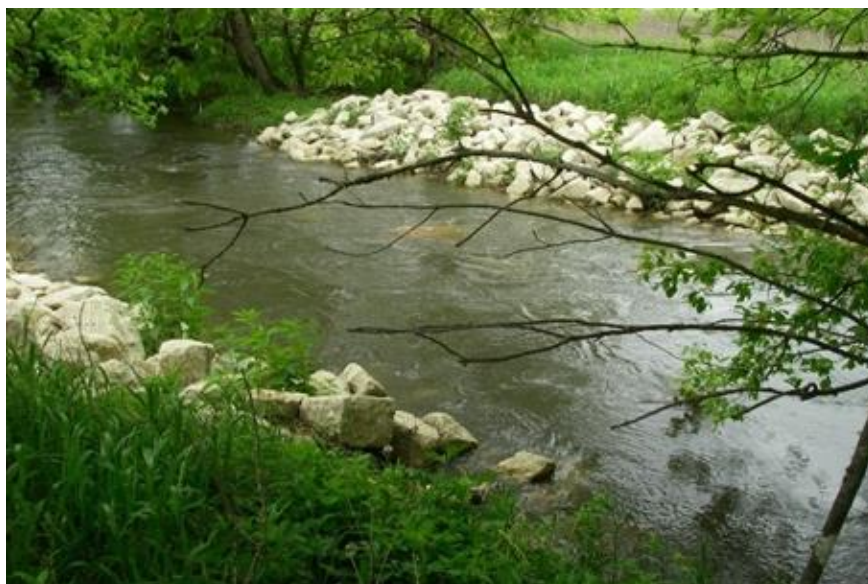
Σχήμα 5.10: Πετρόχτιστος ύφαλος (Πηγή: Τμήμα Διαχείρισης Πόρων της Αϊόβα)
