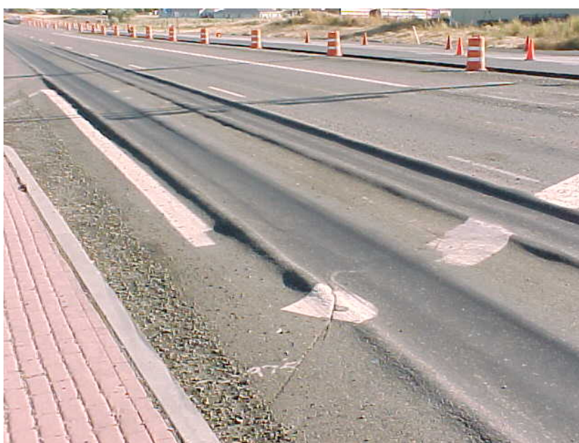
Εικόνα 4.8: Τροχοαυλάκωση ασφαλτικών στρώσεων Πηγή: (Pavement Interactive, 2023)
