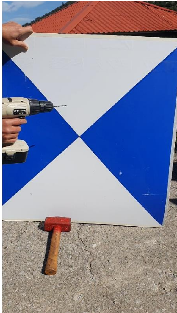
Εικόνα 4.5 Διαδικασία σήμανσης του κέντρου του φωτοσταθερού
