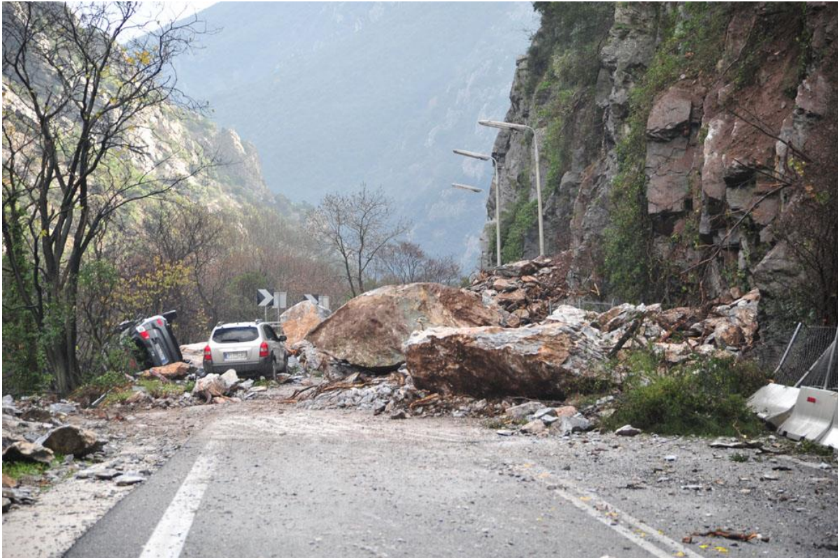
Εικόνα 2.11 Αποτελέσματα κατολίσθησης στα Τέμνη(17/12/2009) ΠΗΓΗ: https://www.elekkas.gr/images/galleries/Tempi-2009/34_12.JPG
