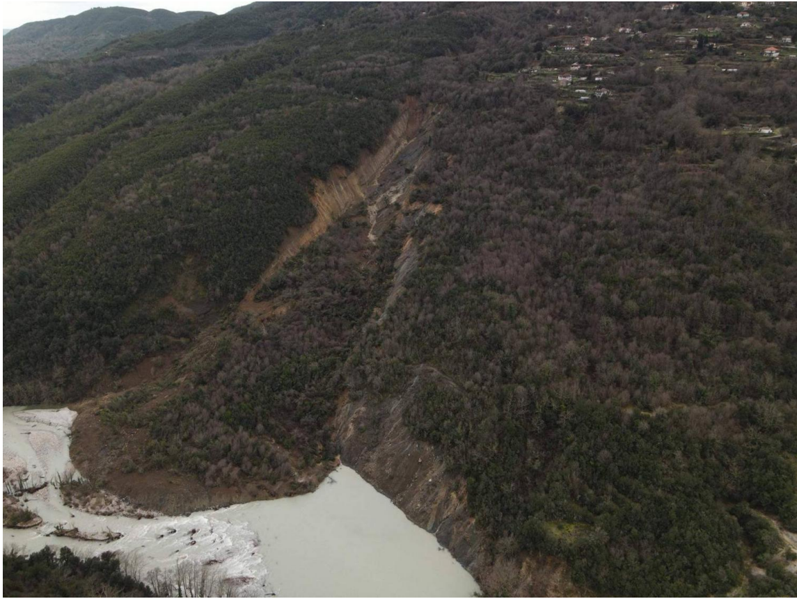
Εικόνα 2.13 Αστοχία πρανούς στην Ζήρο κα στην Άρτα ΠΗΓΗ: https://www.eagme.gr/uploads/gallery/22/152/large.jpg
