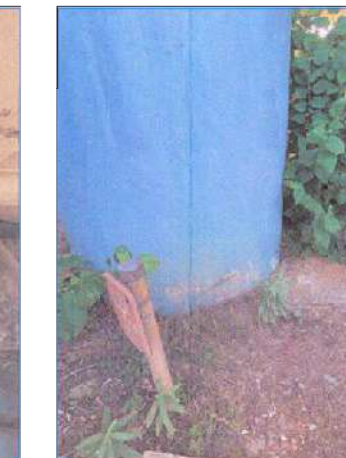
Φ.4 Ίχνη υγρασίας στη βάση
