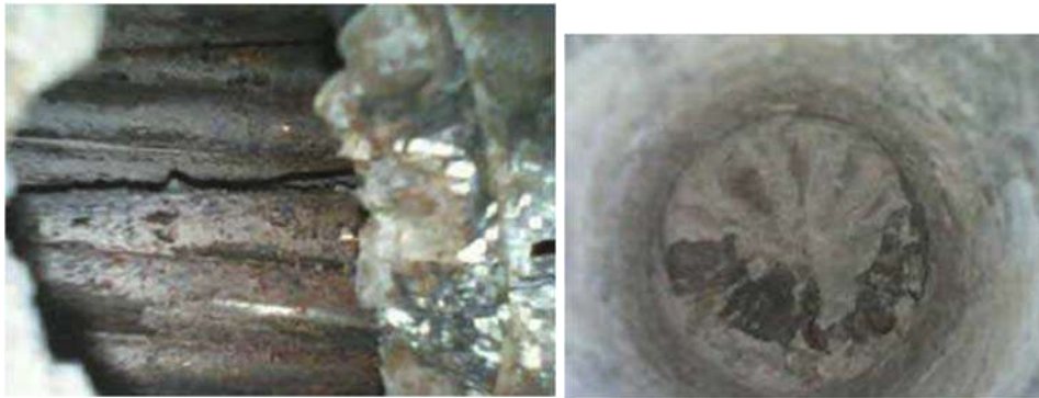
Εικόνα 18. Παράδειγμα διαμήκη τένοντα με ανεπαρκή πλήρωση (αριστερά) και με επαρκή πλήρωση (δεξιά).
