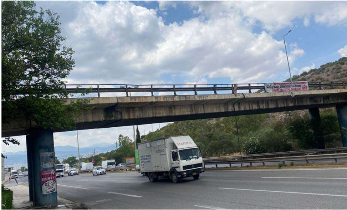
Εικόνα 2. Κεντρικό αιωρούμενο άνοιγμα.
