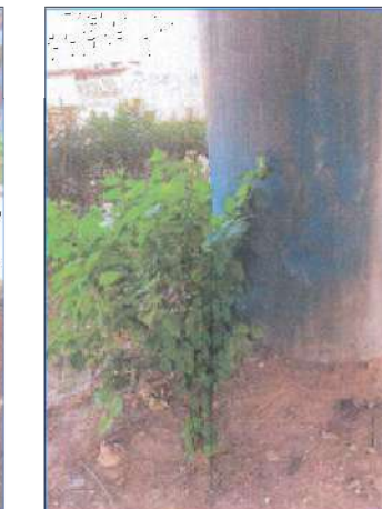
Φ.2 Στόλος προς Κόρινθο, χωματική αλλοίωση και ανάπτυξη βλάστησης
