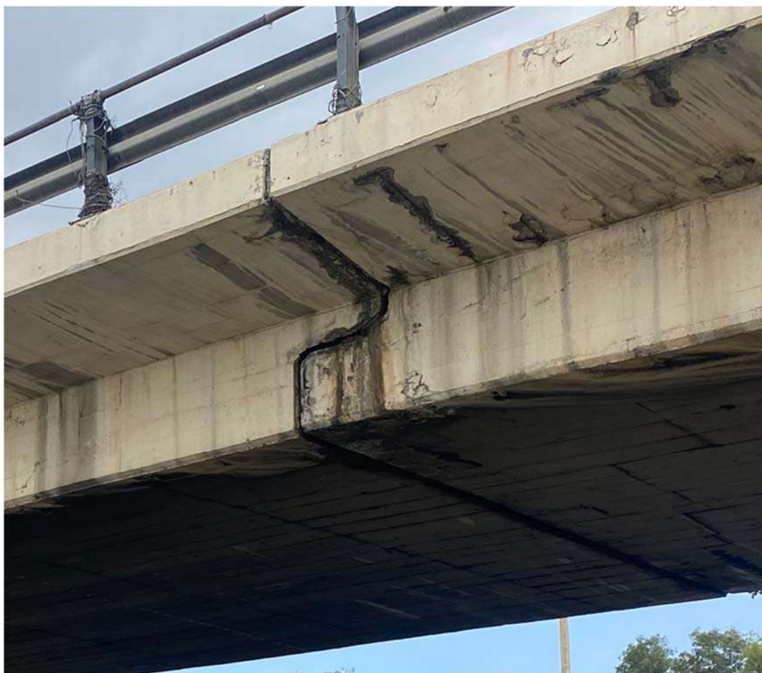
Εικόνα 12. Δοκός Gerber στην υφιστάμενη γέφυρα στη περιοχή Σκαρμαγκά.
