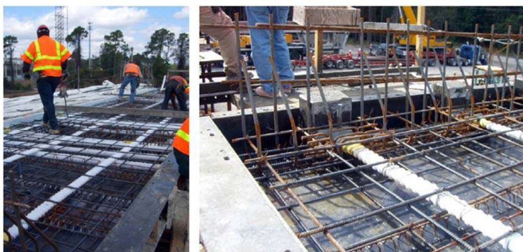
Εικόνα 114. Τυπική διάταξη εγκάρσιου τένοντα (Corven 2016).
