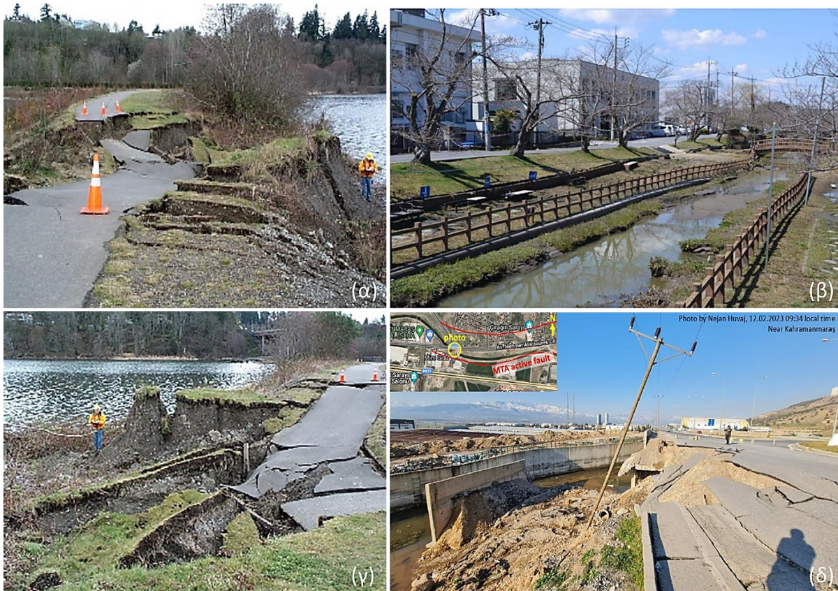
Σχήμα 1.2: Παραδείγματα περιστατικών πλευρικής εξάπλωσης από τους σεισμούς (α) Nisqually (2001), (β) Tohoku (2011), (γ) Nisqually (2001) και (δ) Kahramanmaraş (2023).
