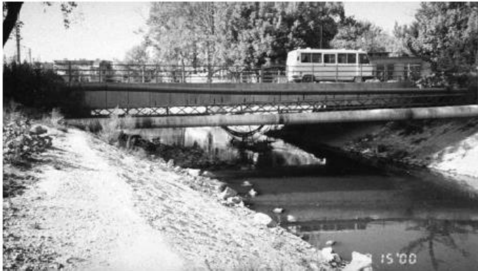
Σχήμα 2.7: Φωτογραφία της τοποθεσίας του καναλιού Çark που δείχνει γέφυρα, αγωγό και κανάλι που δεν υπέστησαν ζημιά κατά τον σεισμό του Kocaeli το 1999 (Youd et al. 2009).
