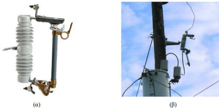
Εικόνα 2.7.4 (α) A/Z MT, (β) Λειτουργία A/Z σε σφάλμα
