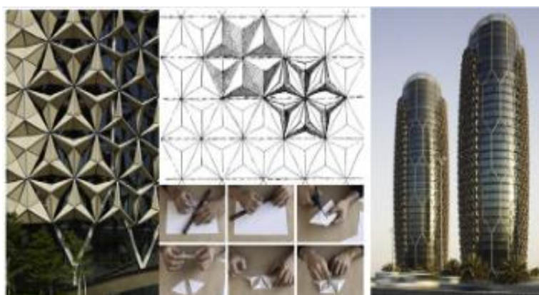
Σχήμα 3-9: Εφαρμογή δομών kirigami στους Πύργους Al Bahar (από Li et al, 2021)
