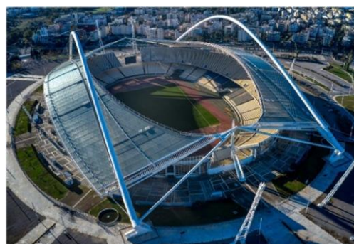
Σχήμα 8.2. Κεντρικό Ολυμπιακό Στάδιο μετά την κατασκευή του “στέγαστρου Calatrava”. (Πηγή: https://www.news247.gr/oikonomia/poia-einai-ta-megala-erga-poy-tha-metamorfosoyn-to-oaka.9547600.html )
