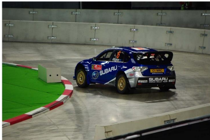
Σχήμα 8.32. Η Υπέρ-ειδική Διαδρομή LEG1 - 2008 του Ιαπωνικού Ράλλυ. Διακρίνονται ο τύπος του οδοστρώματος, των Kerbs, των δύσκαμπτων στηθαίων ασφαλείας (περισσότερο ορθογωνικής διατομής σε σχέση με τις τύπου New Jersey έτσι ώστε να αποδίδονται εύκολα μεγάλες καμπυλότητες στις στροφές), και των ελασμάτων σύνδεσης.
