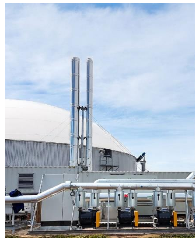
Εικόνα 2.9: Καθαρισμός και φιλτράρισμα βιοαερίου.
