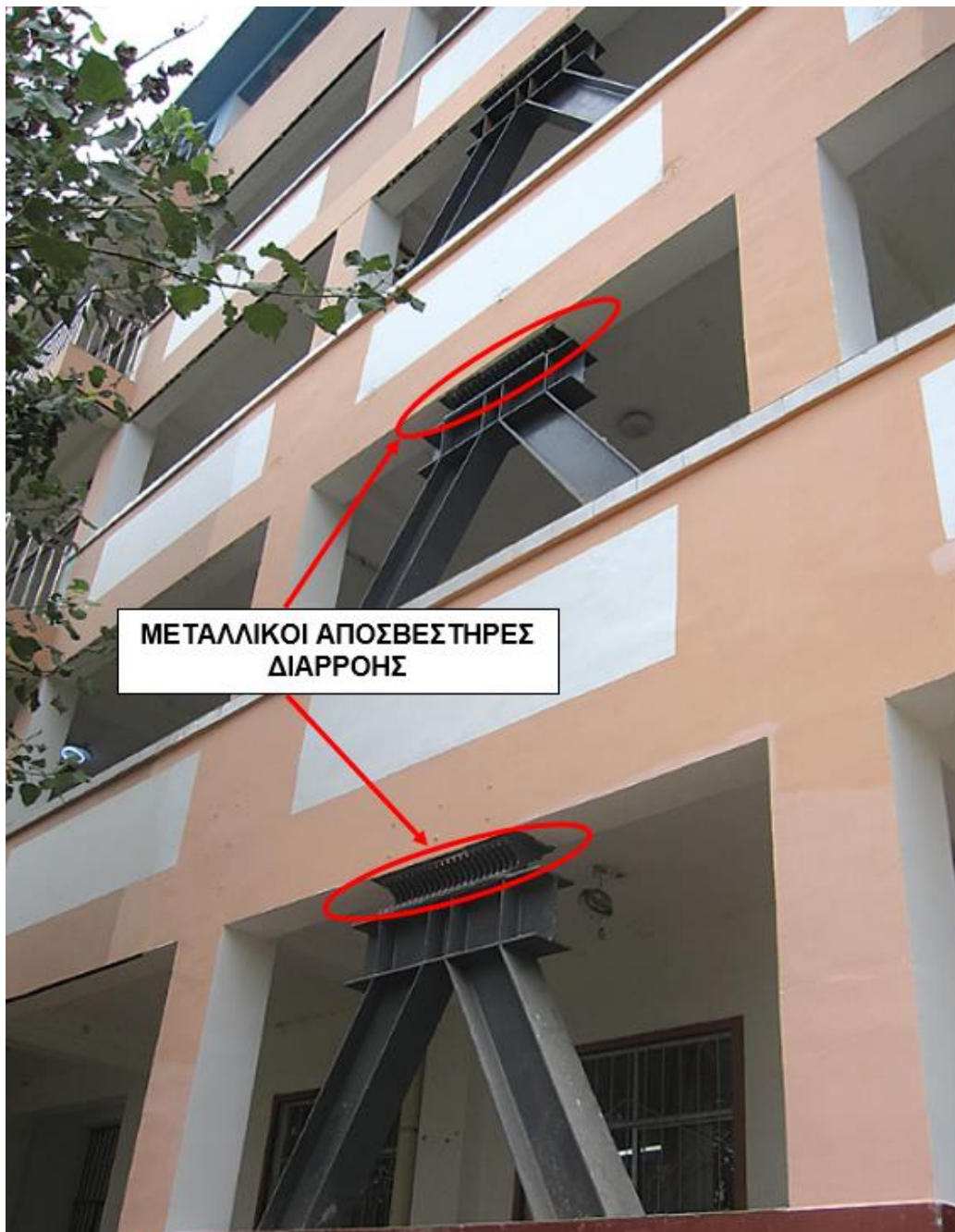
Εικόνα 20: Εφαρμογή μεταλλικών αποσβεστήρων διαρροής σε κτίριο σχολείου
