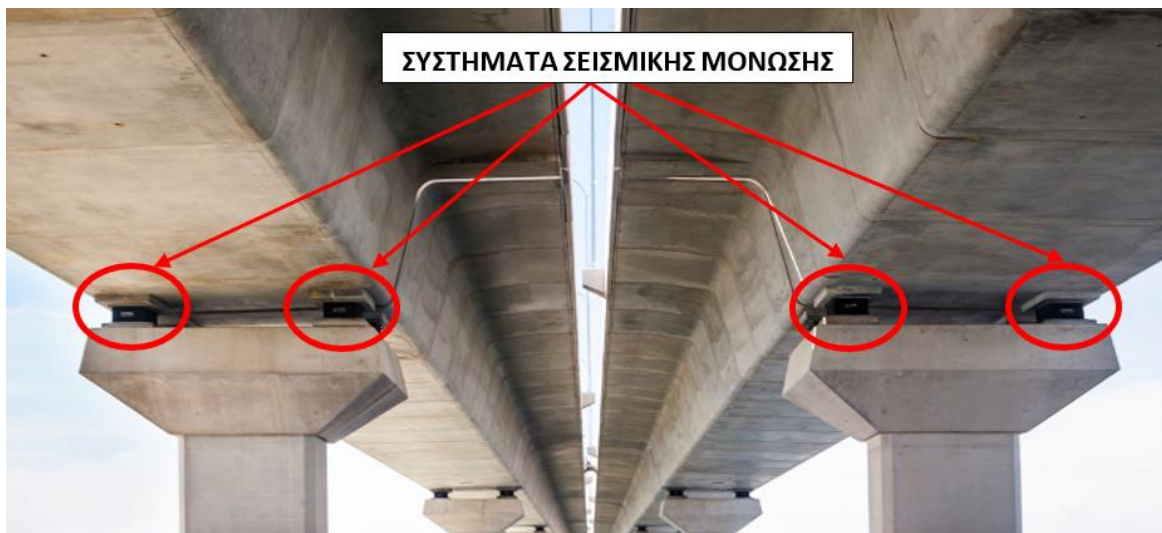
Εικόνα 7: Εφαρμογή συστημάτων σεισμικής μόνωσης σε γέφυρα
