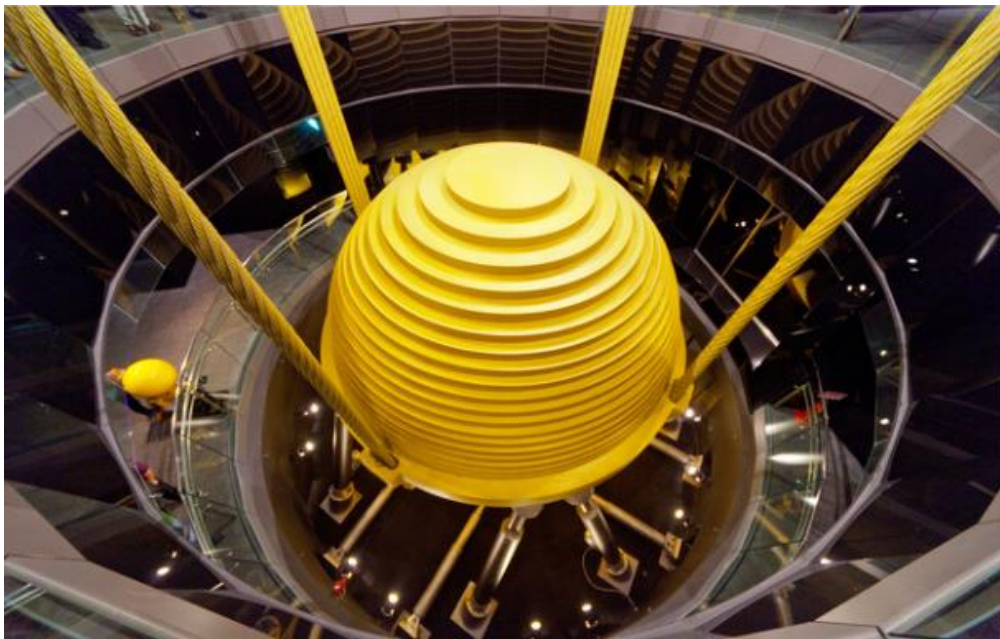
Εικόνα 26: Αποσβεστήρας συντονιζόμενης μάζας στον ουρανοξύστη «Ταίρει 101» (κάτοψη)
