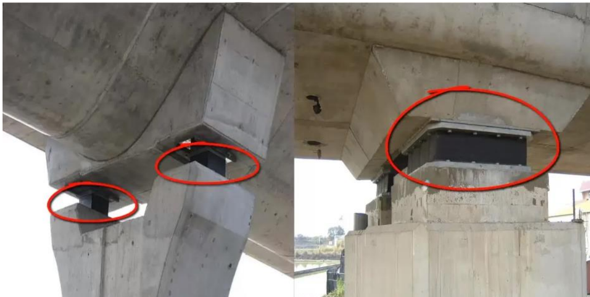
Εικόνα 15: Εφαρμογή ελαστομεταλλικών εφεδράνων σε γέφυρες
