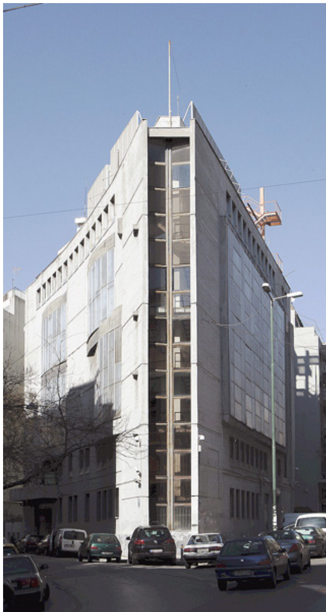
6.4 Σταθμός διανομής ΔΕΗ Κλέων Κραντονέλλης 3ης Σεπτεμβρίου
