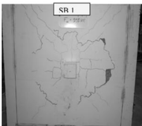
Εικόνα 4.7: Αναπτυσσόμενες ρωγμές κατά τη διατρητική αστοχία του δοκιμίου, πηγή: (ACI Structural Journal, 2005)
