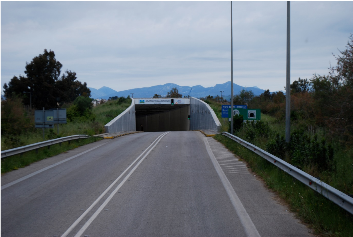
Εικόνα 4: Είσοδος της υποθαλάσσιας σήραγγας Πρέβεζας - Άκτιου
