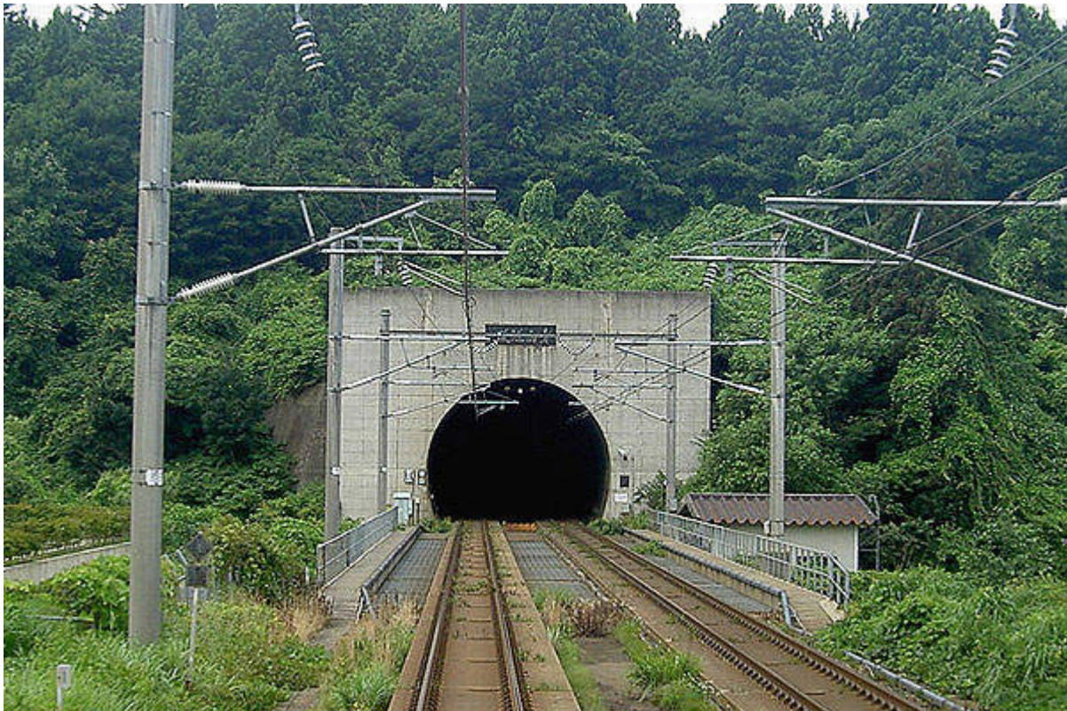
Εικόνα 5: Είσοδος της σήραγγας Seikan στο νησί Honshu
