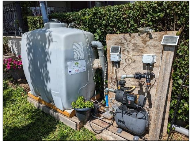
Εικόνα 3.6: Σύστημα Συλλογής ερευνητικού έργου CIRC4Food – Δεξαμενή αποθήκευσης οικίας H02
