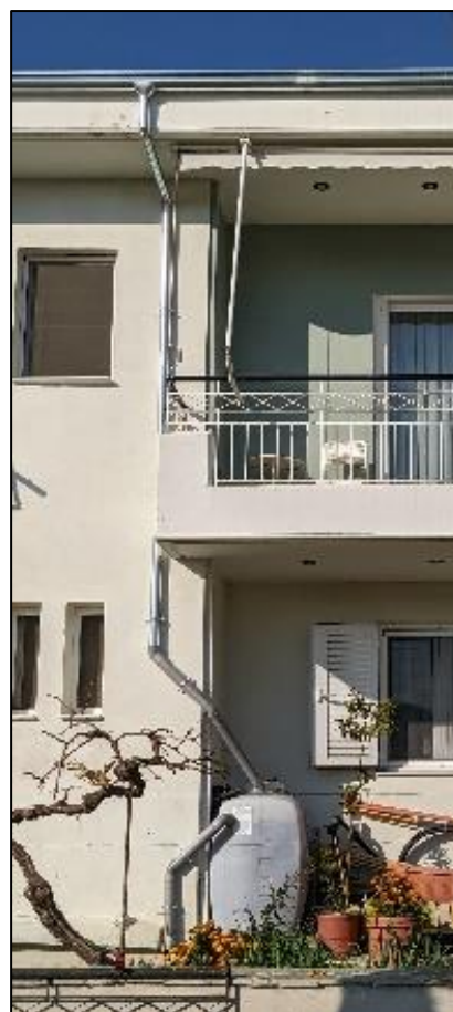
Εικόνα 3.4: Σύστημα Συλλογής ερευνητικού έργου CIRC4Food – Σύστημα συλλογής & αποθήκευσης οικίας H03
