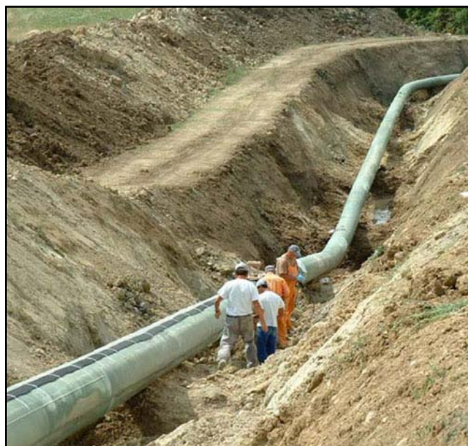
Εικόνα 1.5: Τοποθέτηση SMARTape στον αγωγό φυσικού αερίου.
