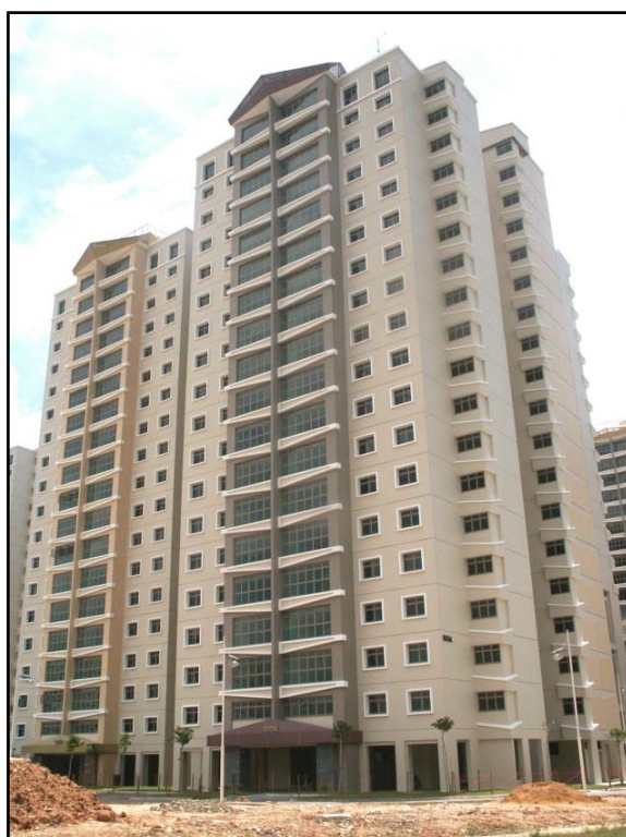
Εικόνα 1.2: Συγκρότημα κτιρίων στην Σιγκαπούρη με εγκατεστημένο σύστημα SHM.
