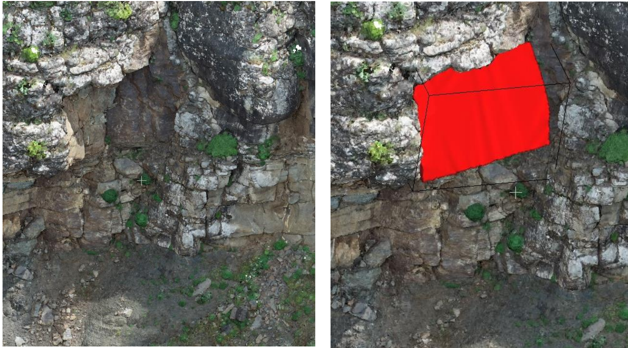
Σχήμα 90. Τμήμα Βραχώμαζας που εκτιμάται πως είχε αστοχήσει σταδιακά
