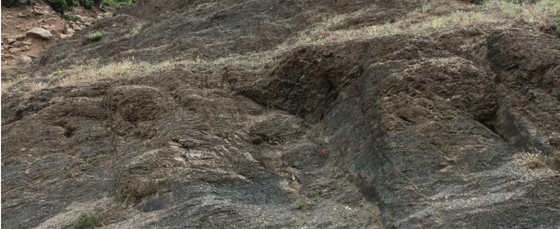
Σχήμα 62. Αποτύπωμα σφηνοειδούς ολίσθησης στην ενότητα II
