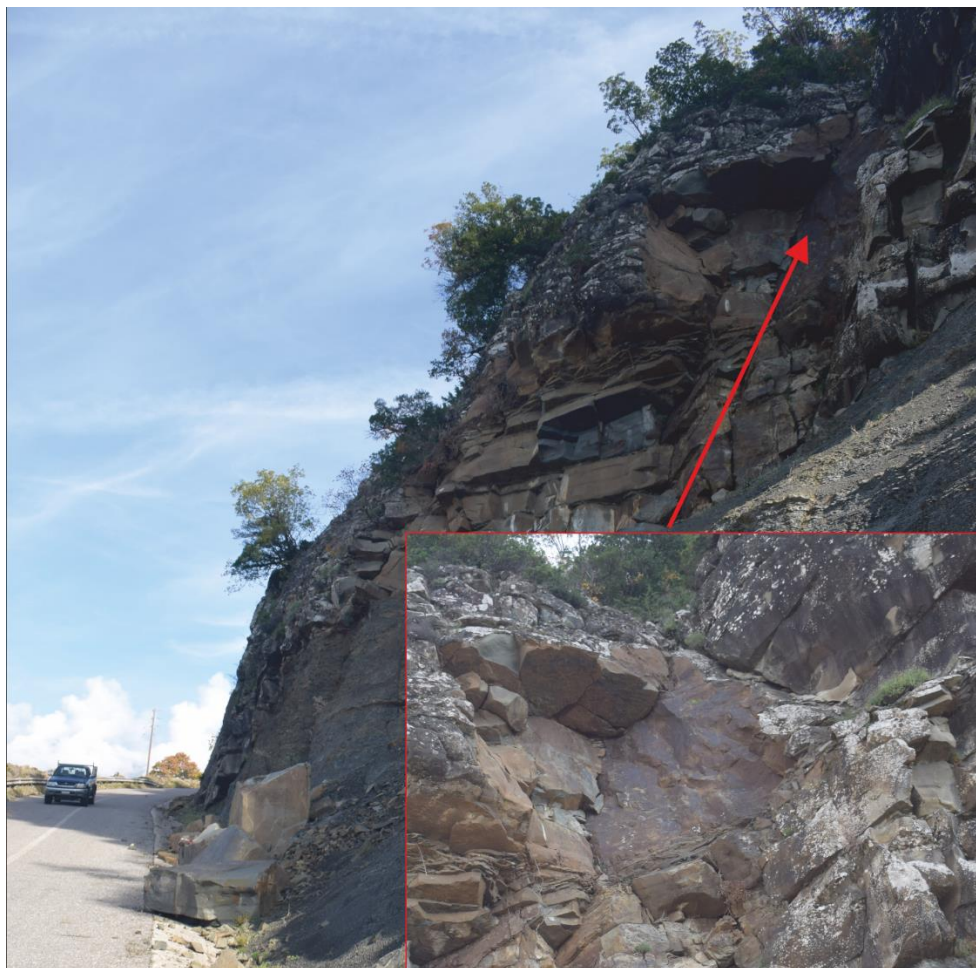
Σχήμα 94. Φωτογραφική αποτύπωση της θέσης όπου προέκυψε το μέγιστο μέγεθος τεμάχους ψαμμίτη της τάξης των 26 \text{ m}^3 βάση της γεωμετρίας των αυλακώσεων από κατάπτωση.
