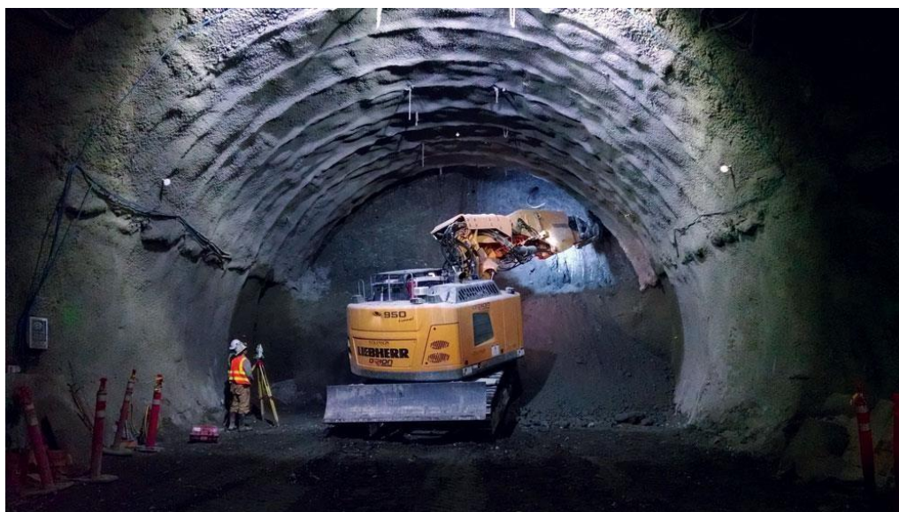
Σχήμα 3. 2 Εκσκαφή με συμβατικά μέσα με τη μέθοδο NATM (Πηγή Sound Transit).
