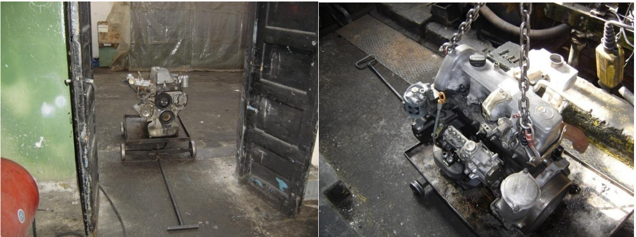
Εικόνα 2.174 Στην αριστερή φωτογραφία απεικονίζεται η είσοδος του τμήματος και κινητήρας M/S 240 επάνω στο καρότσι. Στη δεξιά φωτογραφία, ο κινητήρας έχει αναρτηθεί στη γερανογέφυρα με τη χρήση αλυσίδων.
