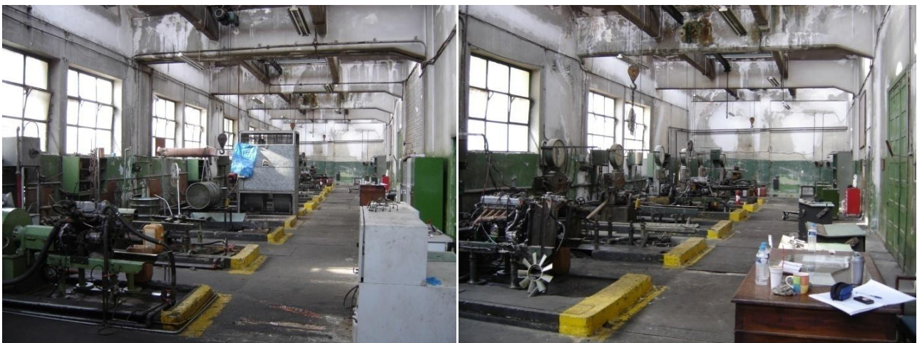
Εικόνα 2.173 Άποψη του τμήματος δοκιμαστηρίου.
