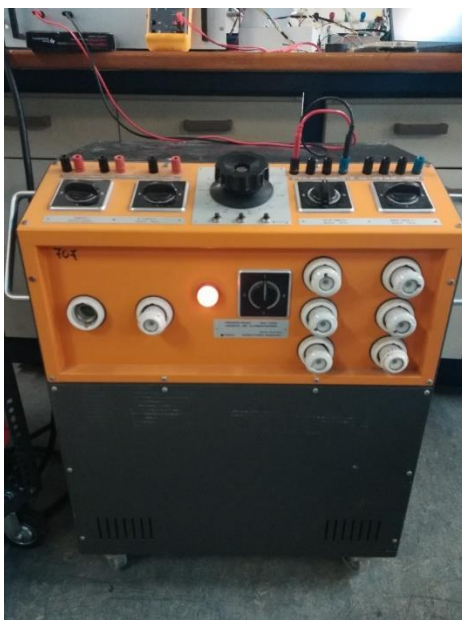
Εικόνα 4.2: Ο μετασχηματιστής τροφοδοσίας του αντιστροφέα.
