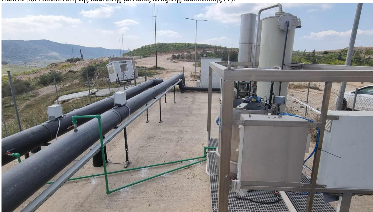
Εικόνα 31: Απεικόνιση της πιλοτικής μονάδας ανοξικής αποθείωσης (2). Είσοδος – Έξοδος βιοαερίου.
