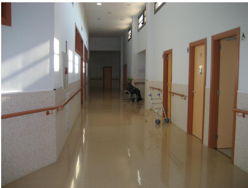
Εικ.3.3 Δάπεδο από μάρμαρο σε διάδρομο νοσοκομείου
