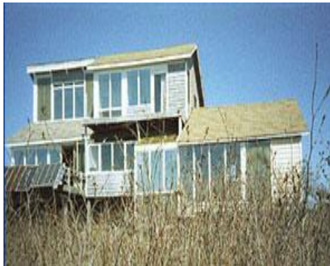
Εικ.1.3 Τα μεγάλα παράθυρα και ο νότιος προσανατολισμός του κτιρίου εκμεταλλεύονται καλύτερα την ηλιακή ενέργεια
